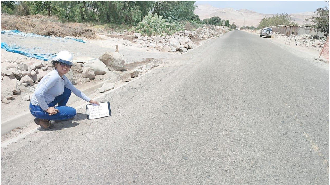
Descripción: En la Imagen se puede observar la Carretera Pampas de San Antonio, donde se realizó la verificación visual del estado de la carretera.
