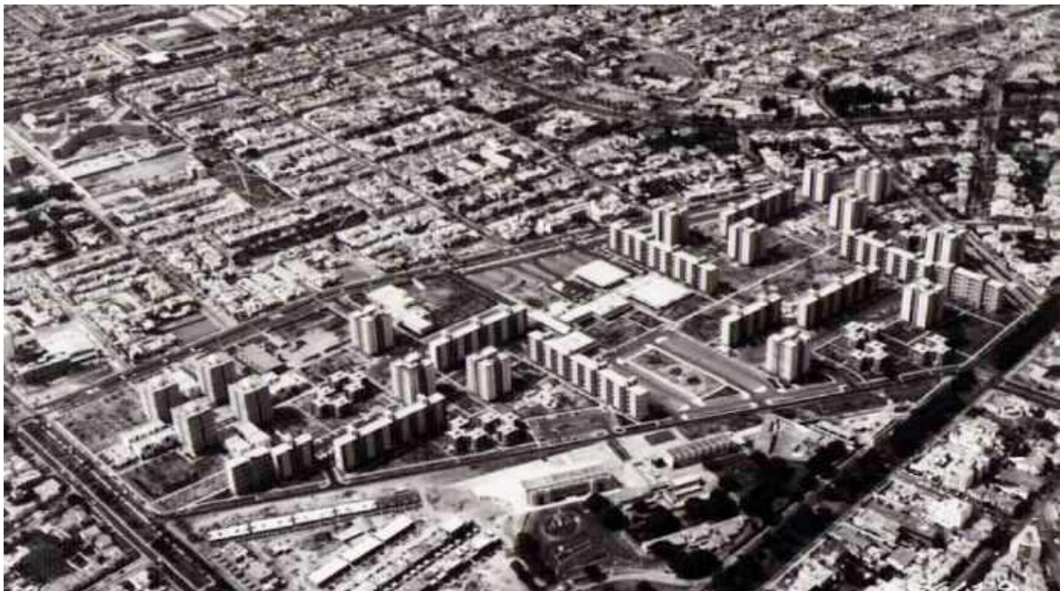
Vista aérea del conjunto residencial San Felipe (1966). Fuente: Servicio Aerofotográfico Nacional del Perú.
