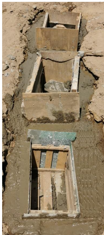
Figura 13. Diseño general del biofiltro
