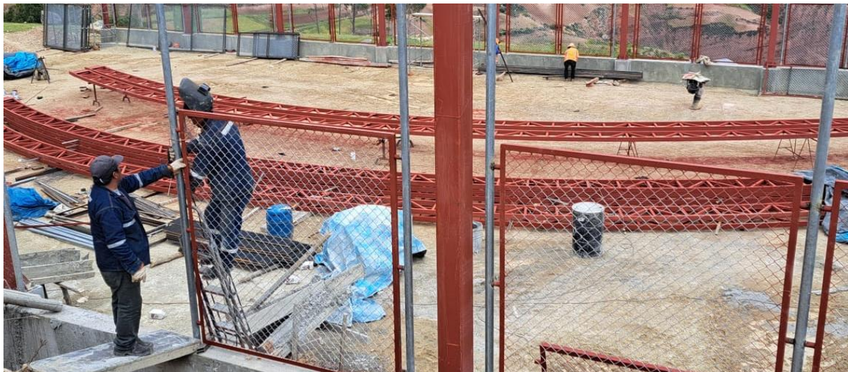
Figura 12. Trabajadores distraídos con su teléfono móvil (creyeron que se le estaba observando)
