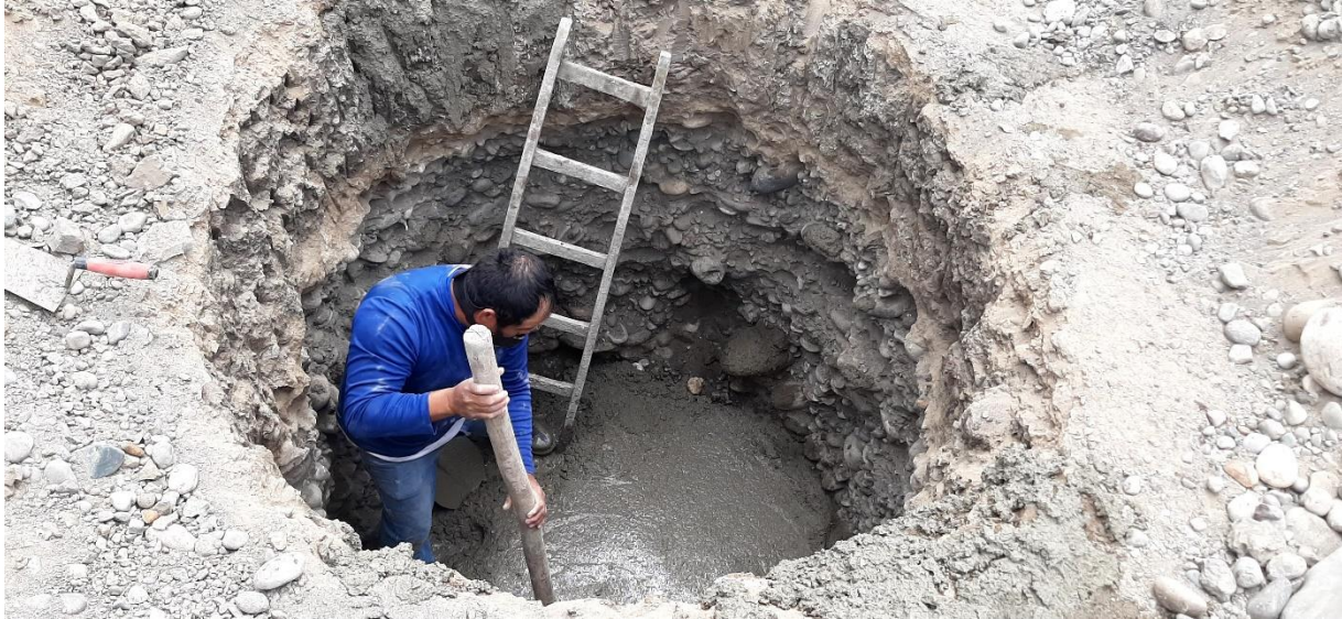
Figura 11. Trabajador sin EPP (Mencionó que estaba apurado) Origen: galería fotográfica de la empresa
