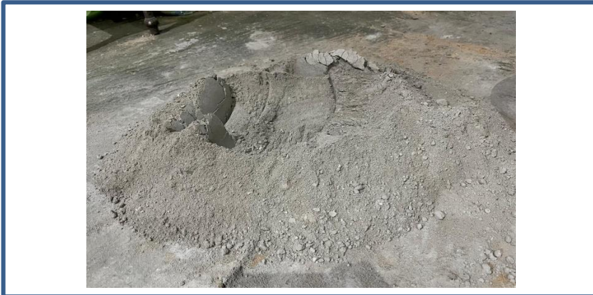
Fotografía 8. Realizando la mezcla manual
