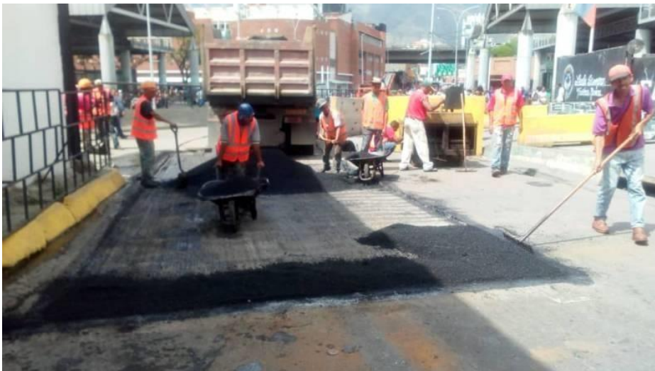
Figura 6. Mantenimiento de una Vía
