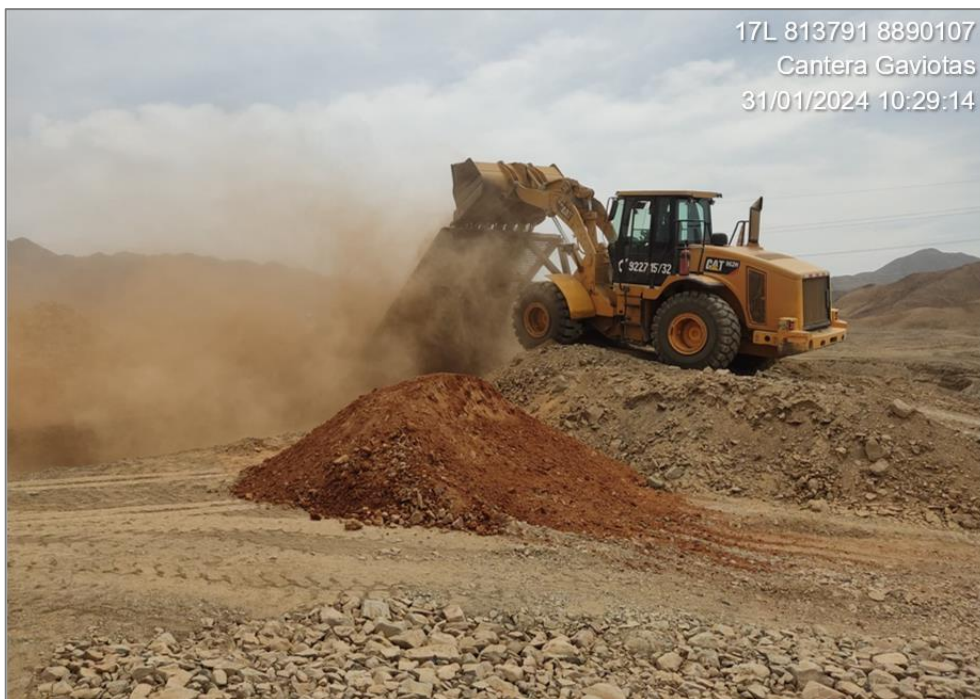
Fotografía 2. Zarandeo de Material Granular en Cantera Gaviotas por Malla de 2" de abertura
