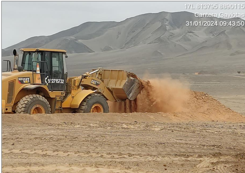
Fotografía 1. Excavación de Material Granular integral en Cantera Gaviotas
