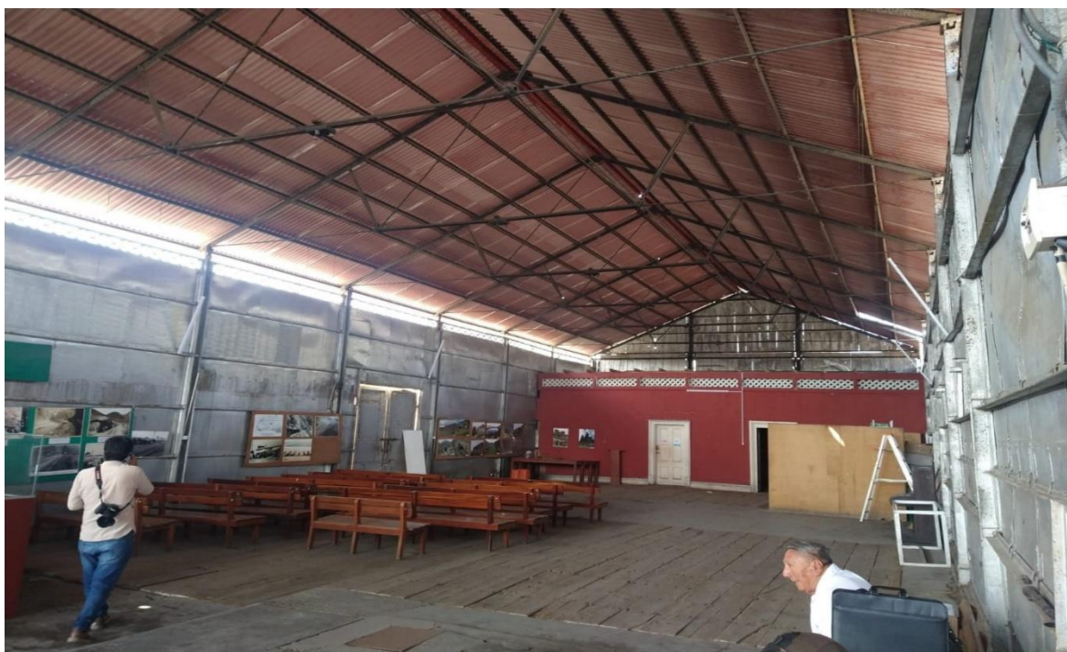
Figura: Vista del interior de la nave principal restaurada hace 17 años.
