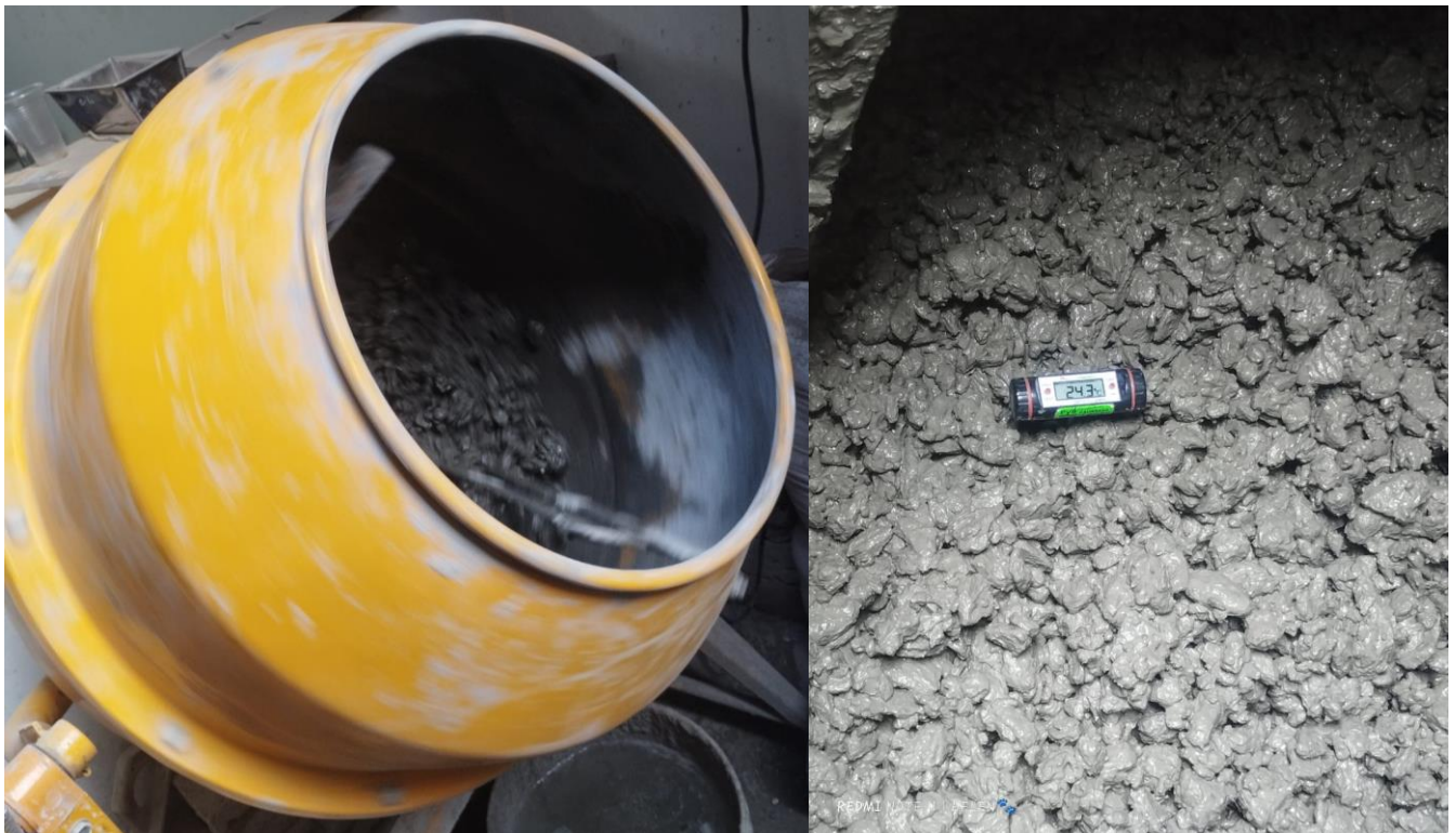
Incorporación de todos los materiales al trompo para poder tener una mezcla optima y al culminar se hizo la toma de temperatura a dicha mezcla.
