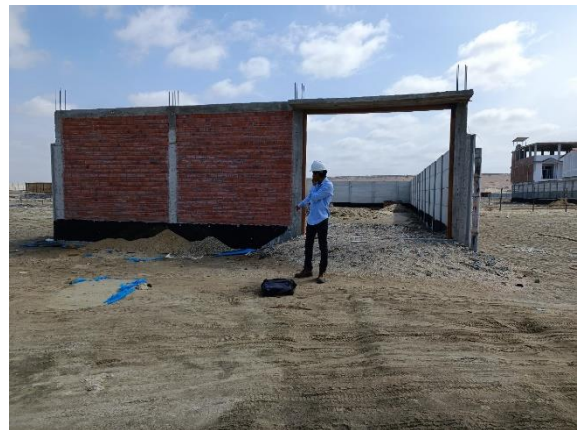
Figura 39: estructuras reparadas y protegidas usando pintura anticorrosiva, impermeabilizantes, plástico grueso y antisalitre.
