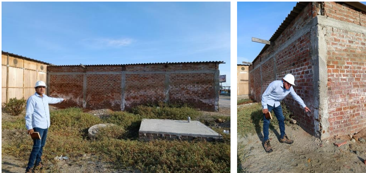
Figura 12: Agrietamiento y pérdidas de sección en columna debido a la corrosión.
