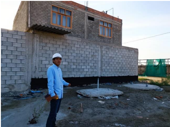
Figura 29: Estructura con protección y/o reparación por impermeabilizantes y anticorrosivos / Estructura sin protección y/o reparación
