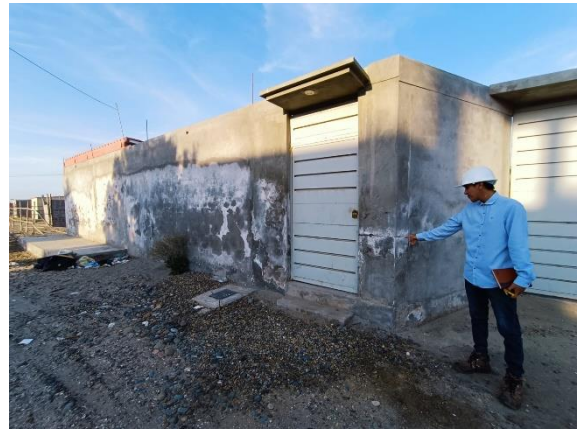
Figura 29: Estructura con protección y/o reparación por impermeabilizantes y anticorrosivos / Estructura sin protección y/o reparación
