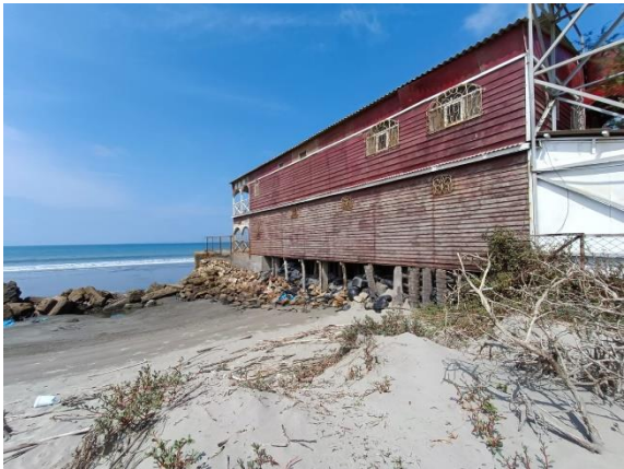
Figura 43: Edificaciones frente al litoral construidas con otros materiales y con pilotes de madera y piedras grandes para su protección
