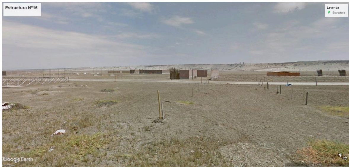
Figura 21: Cerco perimétrico construido antes del año 2015
