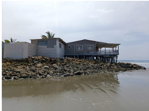
Figura 43: Edificaciones frente al litoral construidas con otros materiales y con pilotes de madera y piedras grandes para su protección
