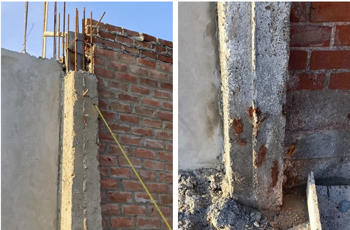
Figura 28: Corrosión afectando las zonas expuestas del acero
