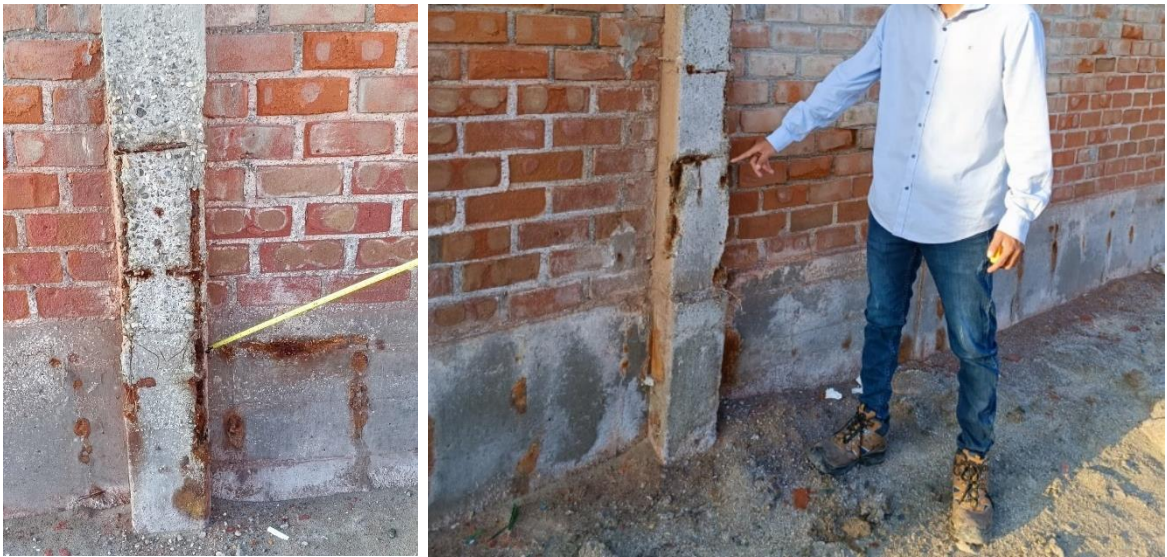
Figura 28: Corrosión afectando las zonas expuestas del acero
