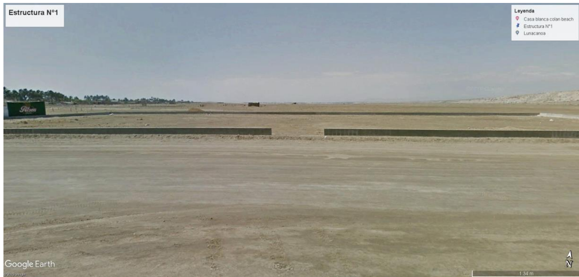
Figura 9: Sobrecimiento construido antes del año 2015
