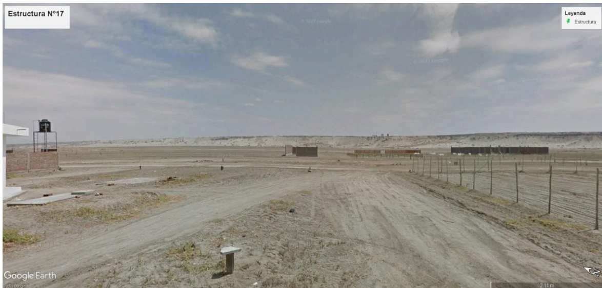
Figura 25: Cerco perimétrico construido antes del año 2015
