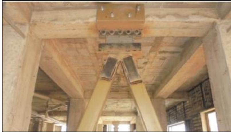
**Figura 5.** SLB para la adaptación sísmica del hotel Ceibo Dorado - Ecuador.
