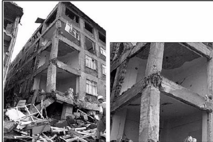
**Figura 7.** Gran Deterioro efectuado en las instalaciones en varias viviendas en Turquía.
