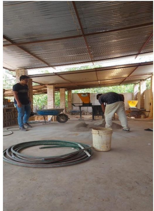
Figura 7: Realizando la mezcla de los materiales del ladrillo ecológico.
