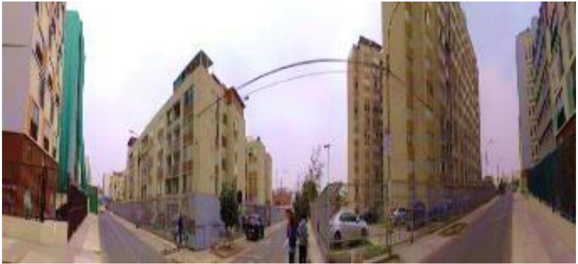
Figura 6. Vista exterior 1, zona - 4, Ex-Aeroclub Collique - 2023.
