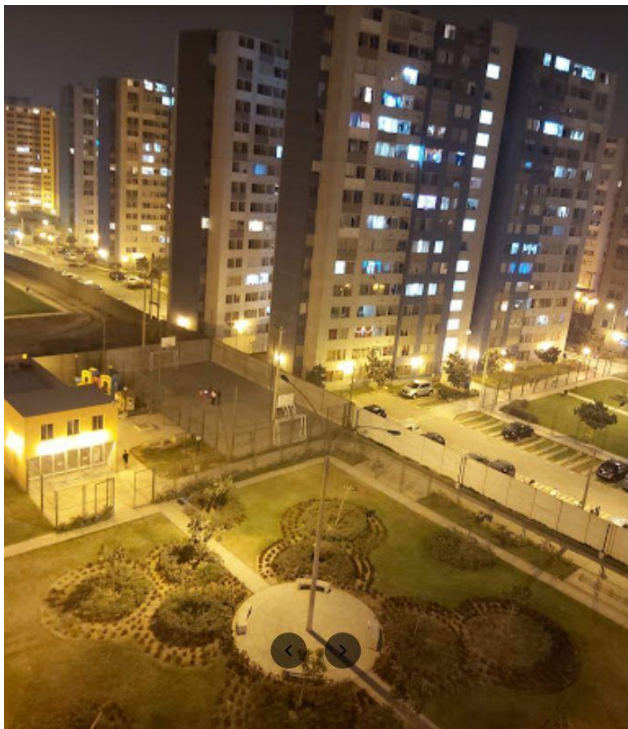
Foto 14: Vista nocturna del espacio público del Condominio - Ciudad del Sol.
