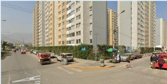
Foto 3: Vista isométrica del condominio Los Laureles. Fuente: Propia.
