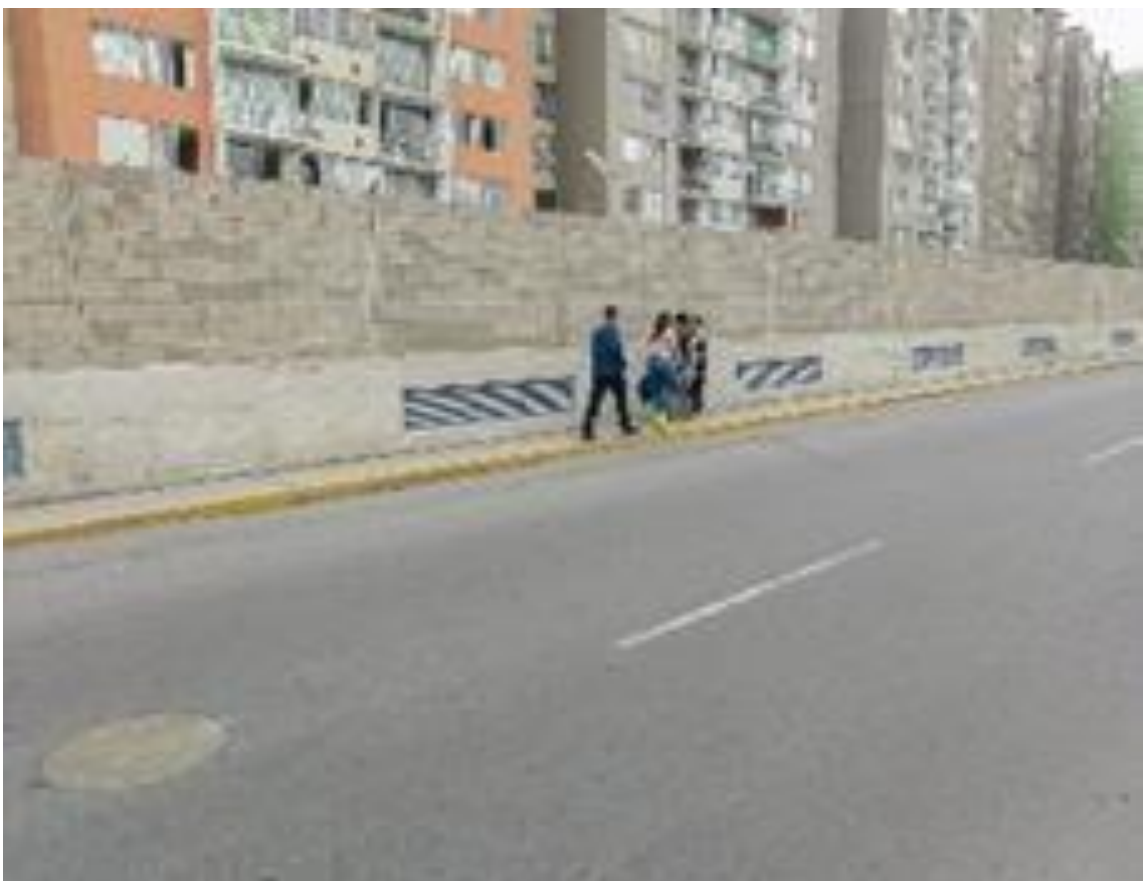
Figura 7. Vista exterior 2, zona - 4, Ex-Aeroclub Collique - 2023.
