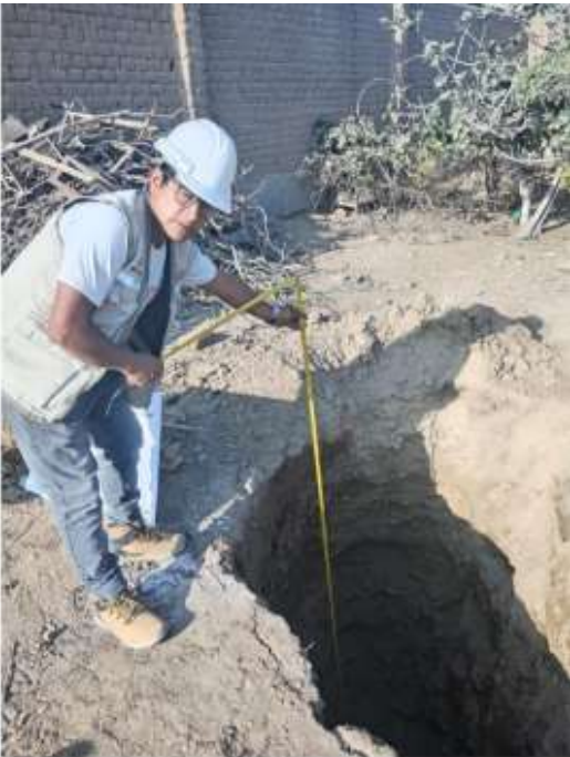
Figura 8: Vista interior de la calicata C-2, evidenciando el perfil estratigráfico
