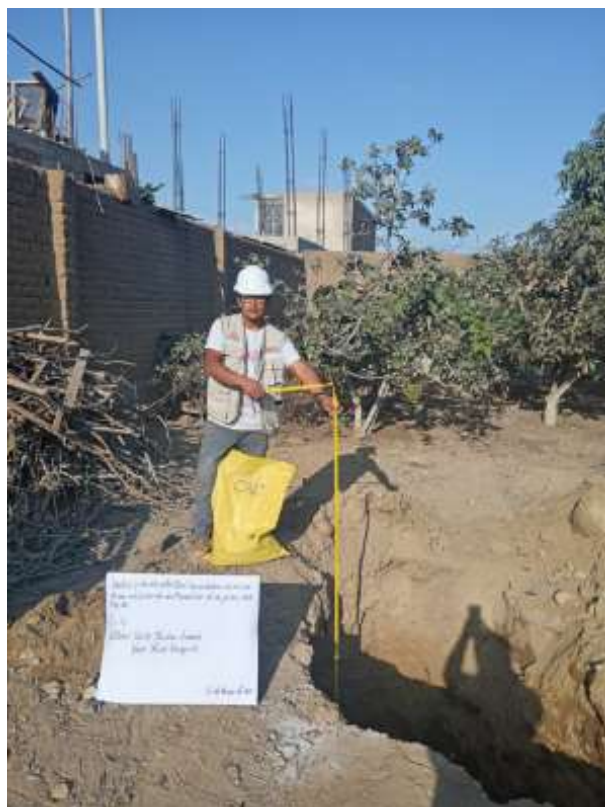
Figura 4: Vista panorámica de la calicata C-2
