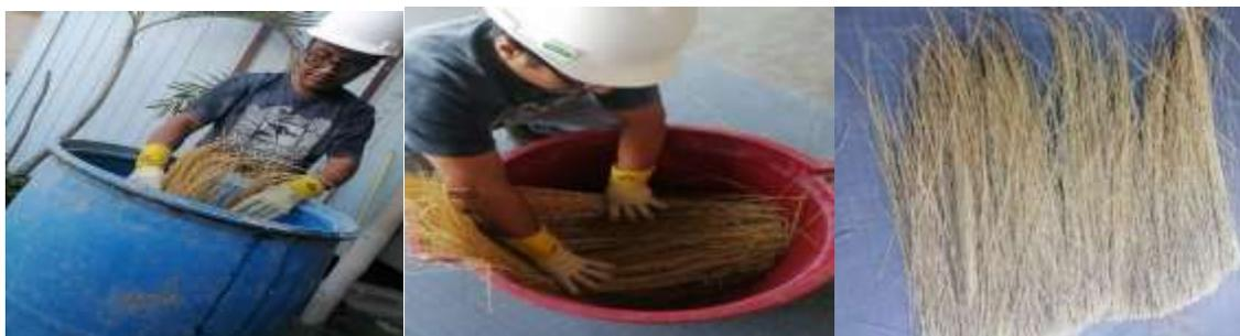
Figura 5. Lavado del ichu con cal y secado de la paja ichu
