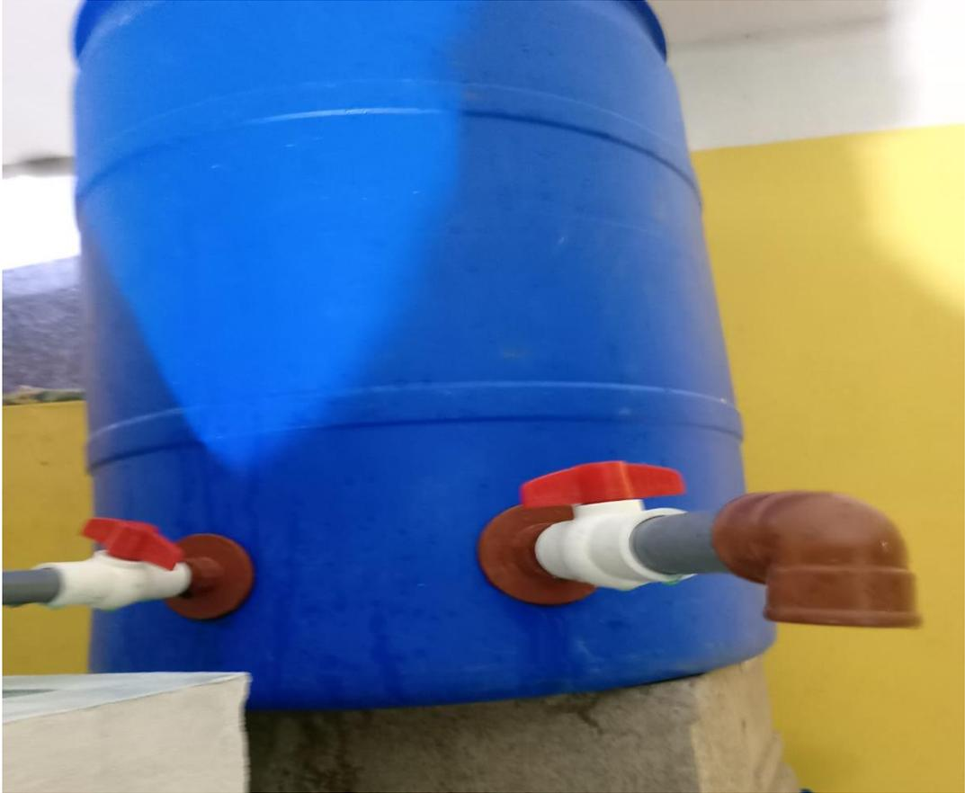
Figura 34. Tanque elevado con dos salidas de agua - tubería de 1" y 1/2".
