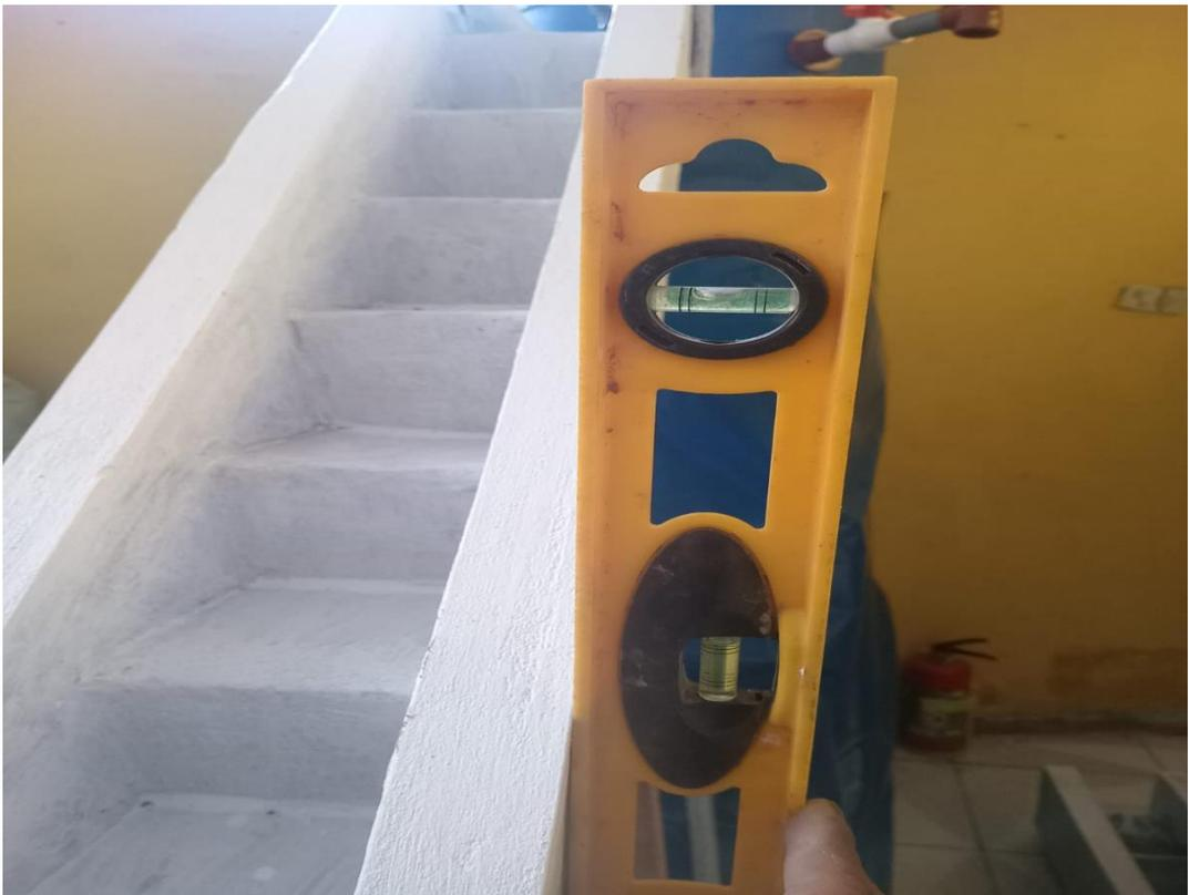
Figura 35. Nivelación manual de los Prototipos antes de las pruebas hidráulicas.
