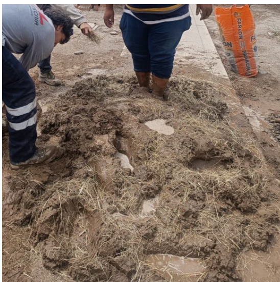
Figura 11. Mezclado de la tierra y paja Fuente: Elaboración propia
