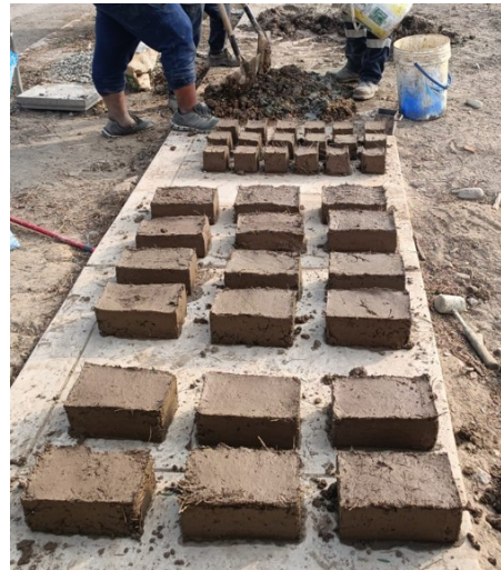
Figura 14. Desmoldeado de de adobe.
