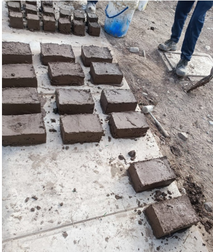
Figura 13. Desmoldeado de Ladrillos Ladrillos de adobe.
