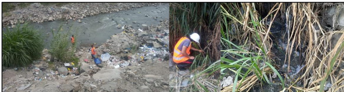
Figura 5: Filtración de aguas residuales domésticas
