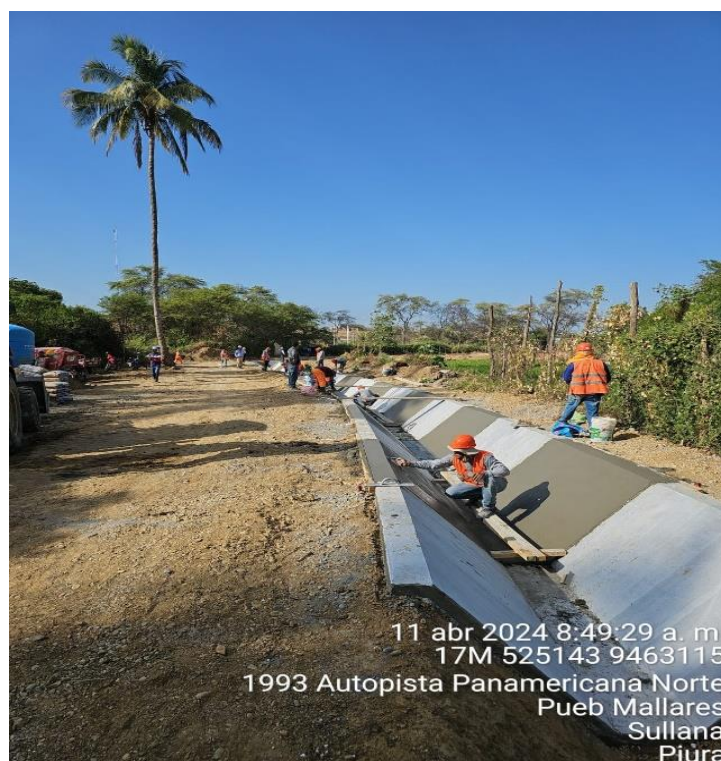
Figura 6: Mejoramiento del servicio de agua del sistema de riego en el centro poblado de Mallares
