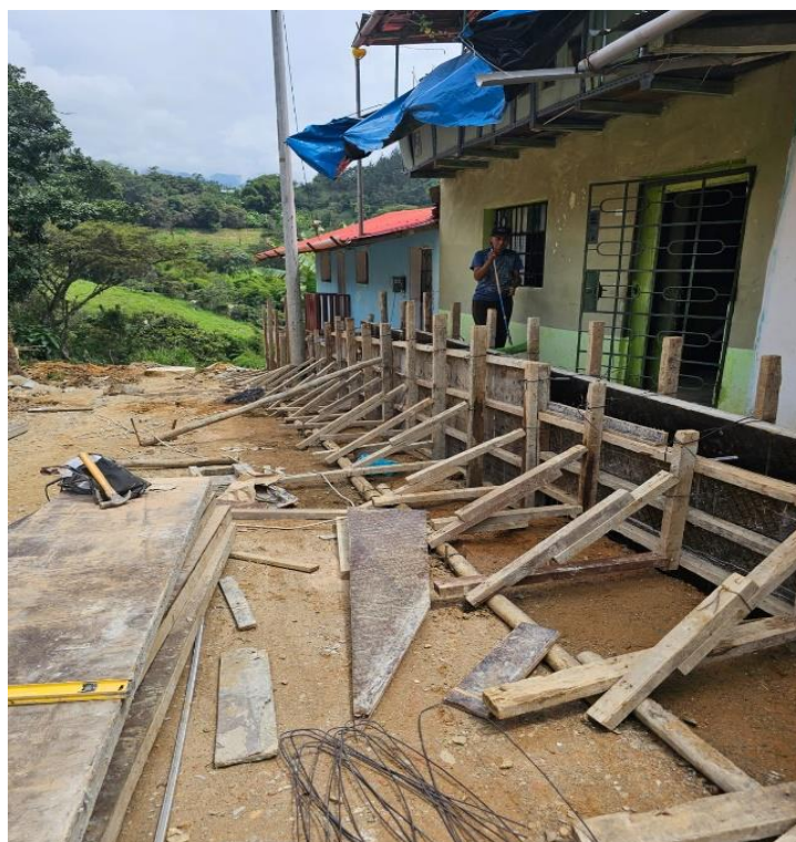
Figura 5: Reconstrucción de calles en la Provincia de Morropón
