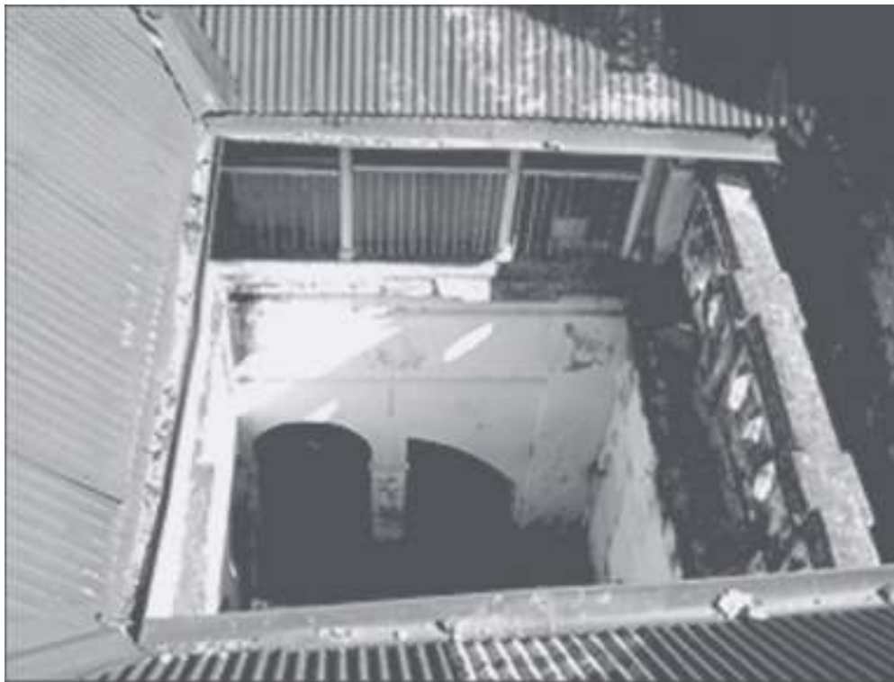
Figura 1. Propuesta de conservación arquitectónica de Kashinath Bhaban Fuente: Google Earth
