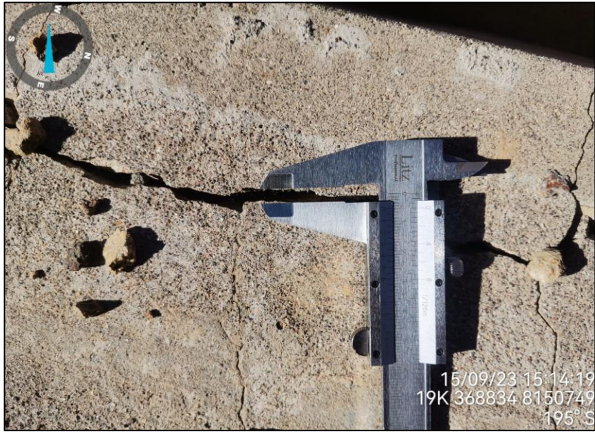
Fotografía 3. Evaluación de grietas y fisuras con vernier en la corona del canal en la progresiva 0+100.
