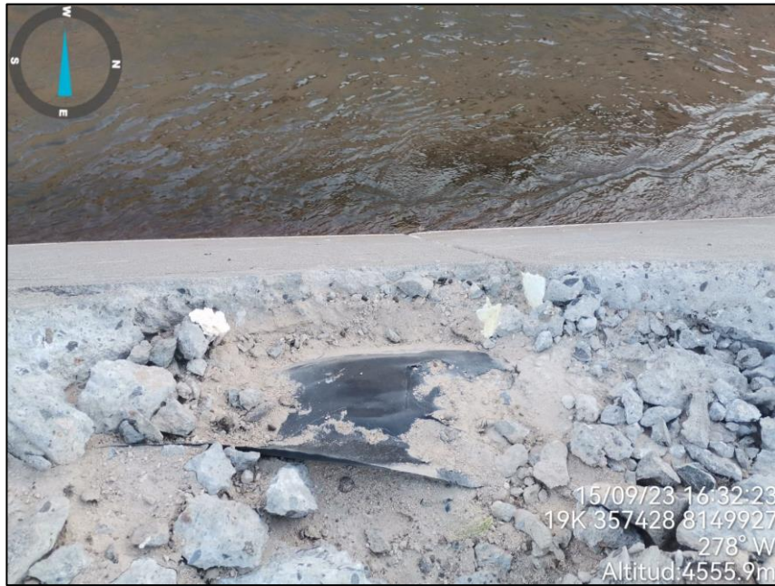
Fotografía 13. Canal Pasto Grande erosionado
