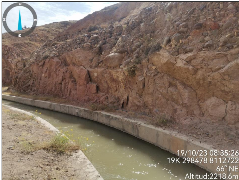
Fotografía 13. Canal Pasto Grande erosionado
