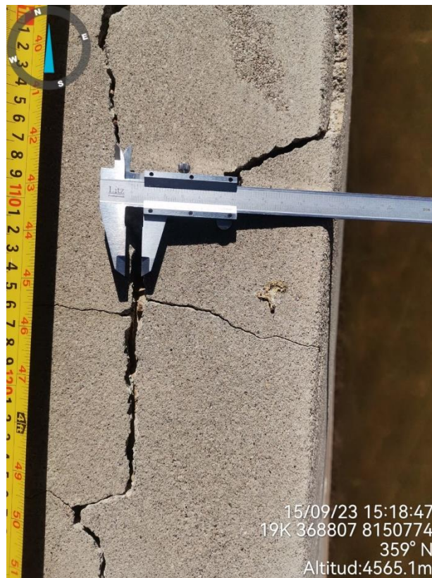
Fotografía 3. Evaluación de grietas y fisuras con vernier en la corona del canal en la progresiva 0+100.
