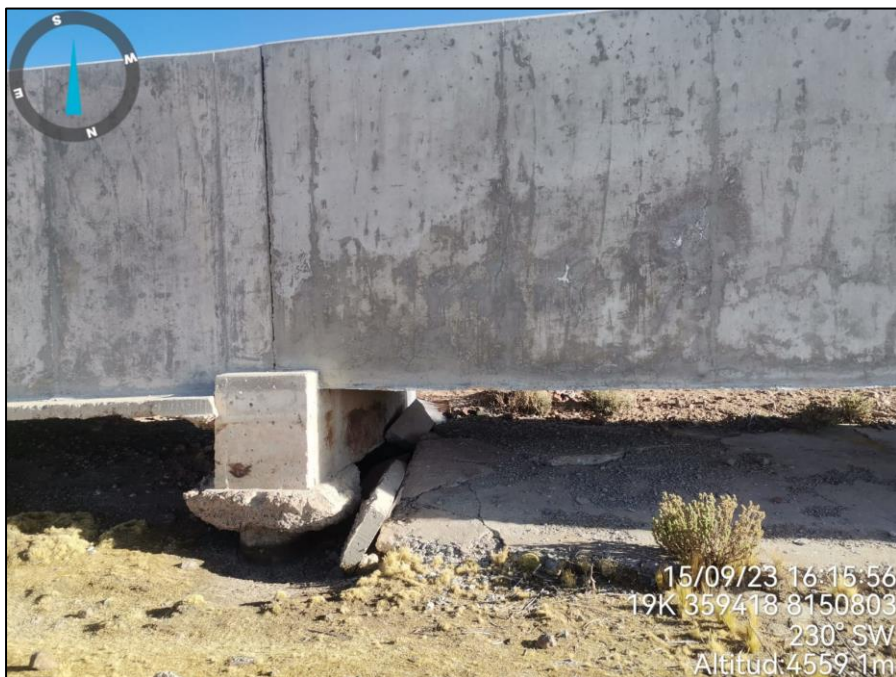
Fotografía 11. Erosión del talud por efecto de las intensas lluvias
