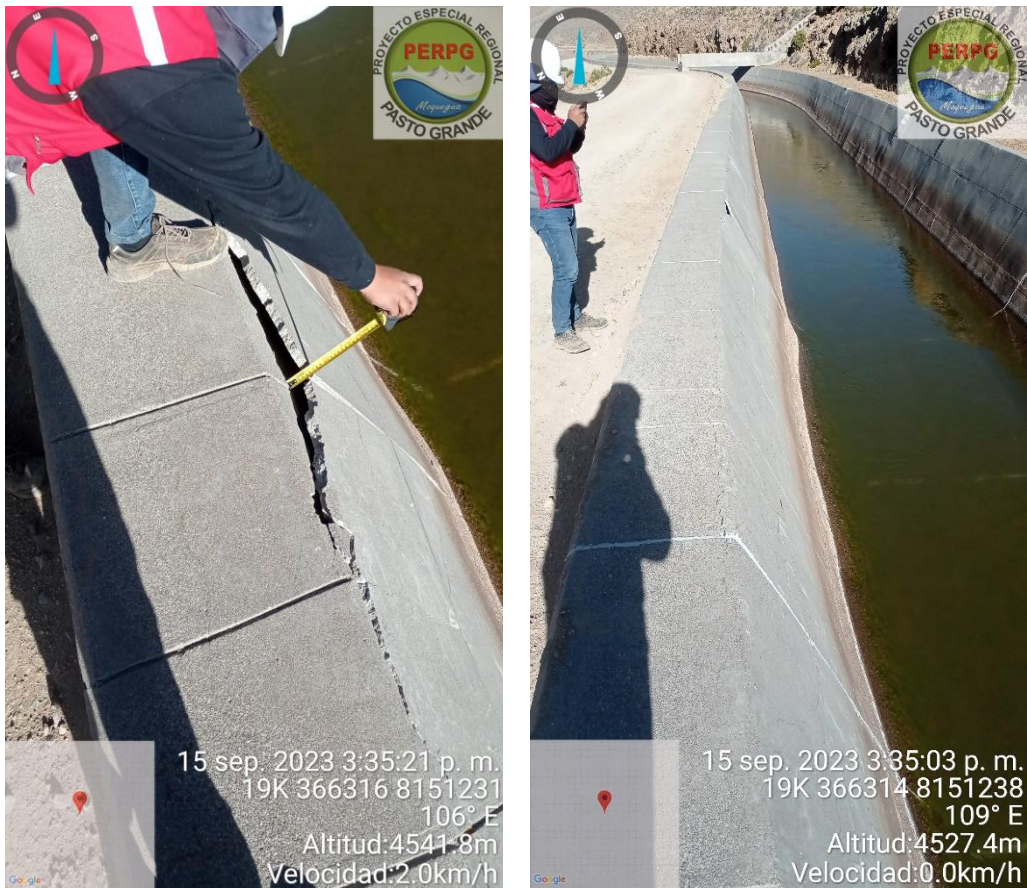
Fotografía 23. Levantamiento de información en el canal del Sistema Pasto Grande
