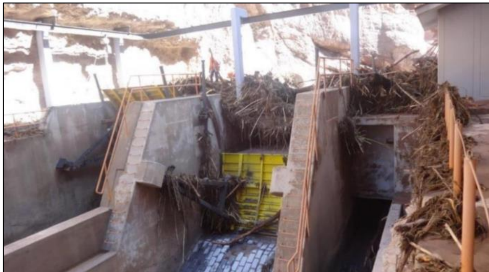
Fotografía 20. Afectación de la Bocatoma Estuquiña en el año 2015 por las lluvias intensas en la parte alta
