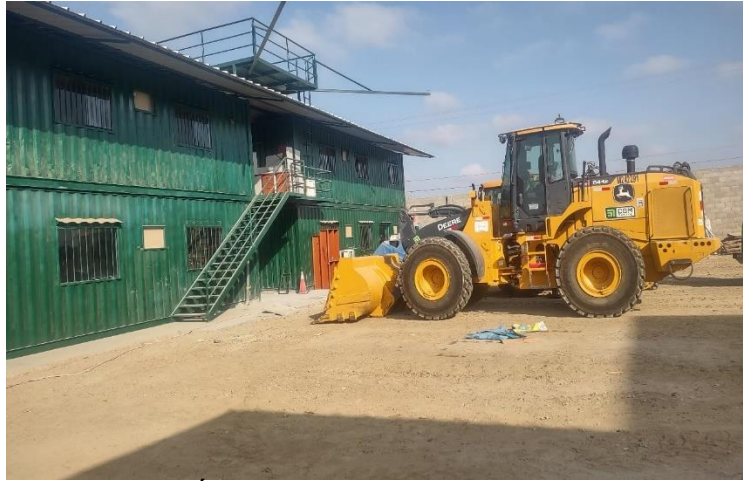
Figura 7 Área externa– Ubicación de la maquinaria
