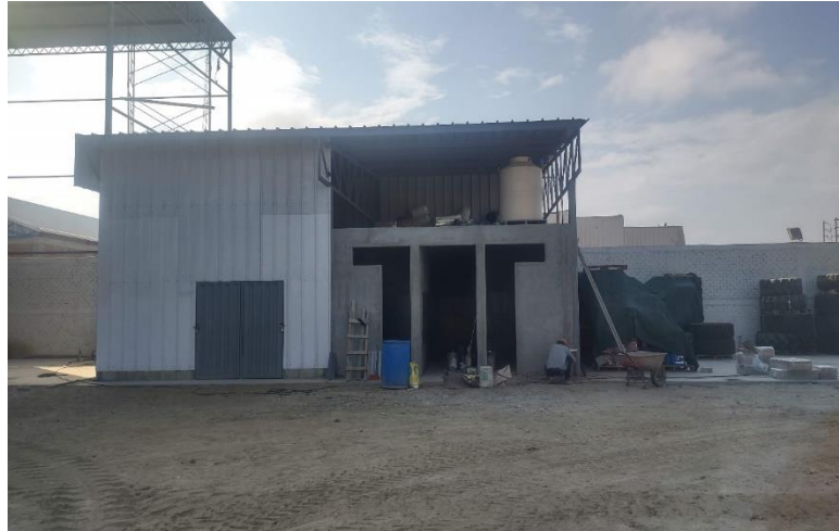
Figura 9 Área externa– Futura ubicación de la maquinaria
