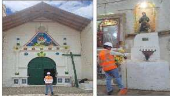
Figura: Elementos no estructurales de la iglesia
