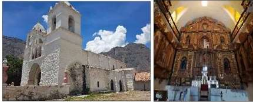
Figura: Elementos no estructurales de la iglesia
