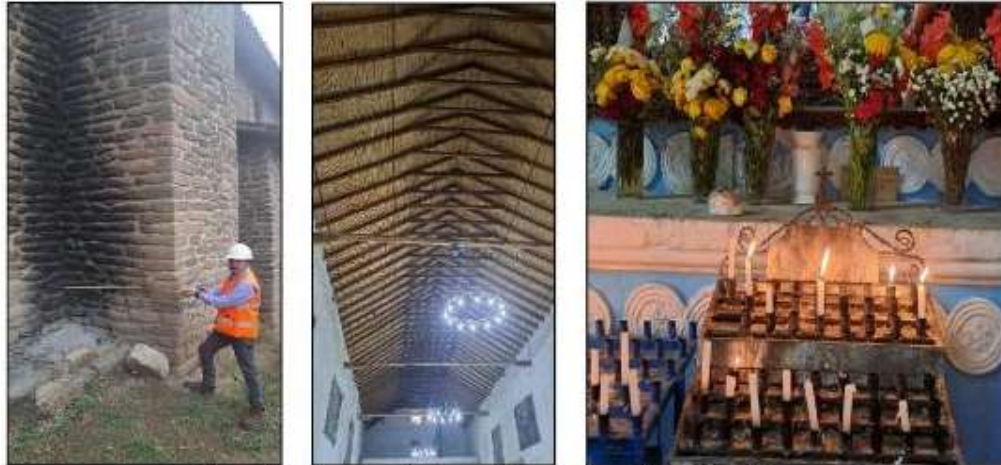
Figura: Se presencia cobertura y elementos de madera inflamable.
