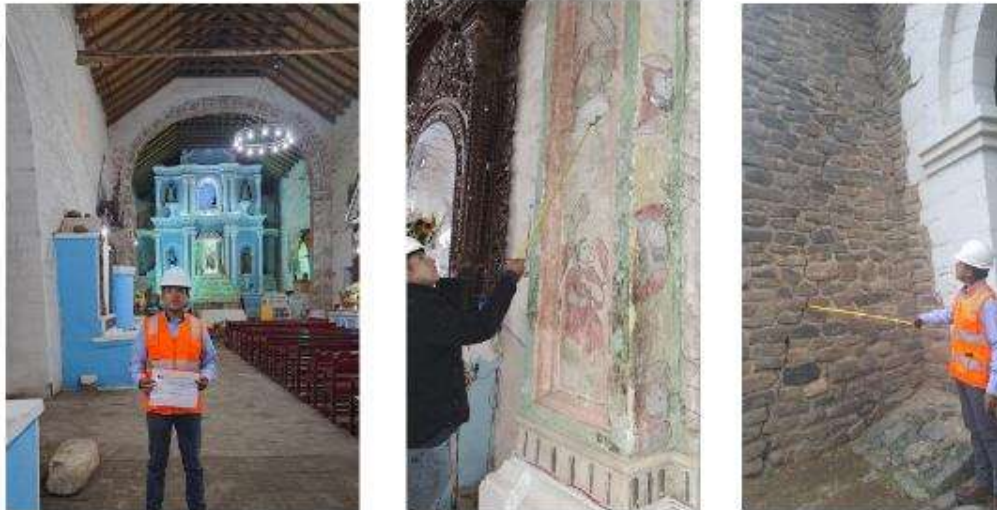
Figura: Se evidencia que la bóveda no presenta deformación interna
