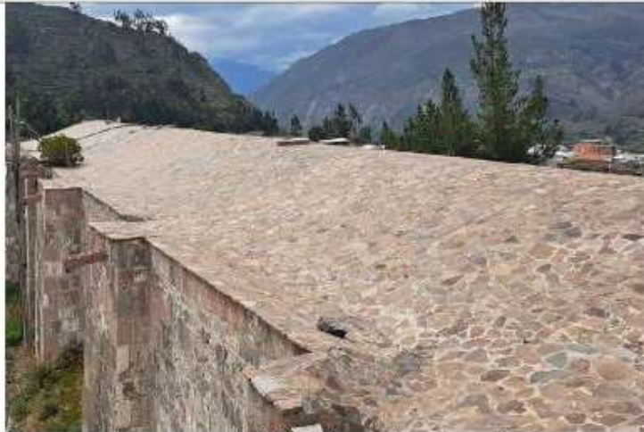
Figura: Continuidad de la cubierta cubierto con piedra laja.
