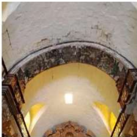
Figura: Deformación del diafragma
