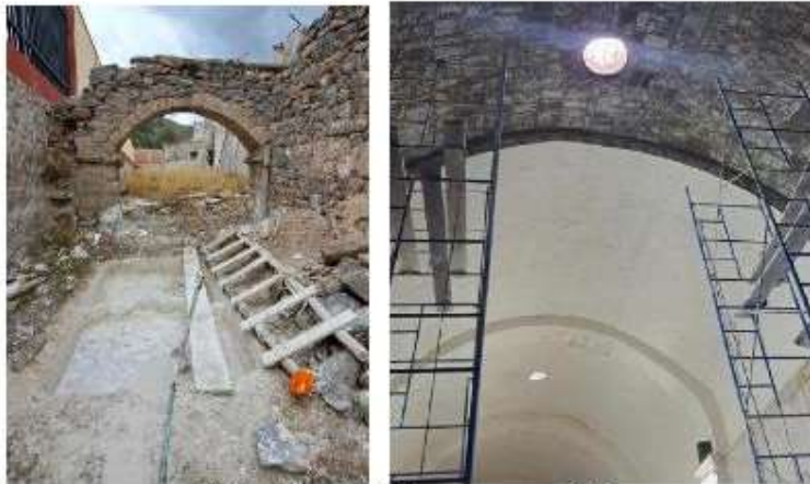
Figura: Reparación de manera superficial.
