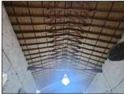
Figura: La bóveda presenta deformación despreciable. Figura: Conexión eficiente con elementos verticales
