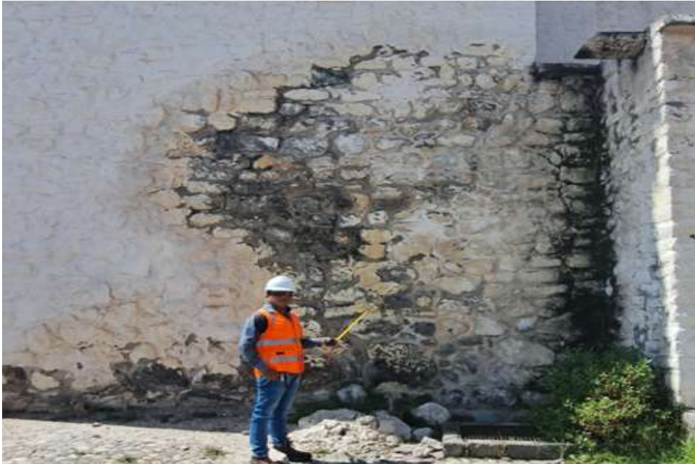
Figura 33. Muros con mampuestos distintos
