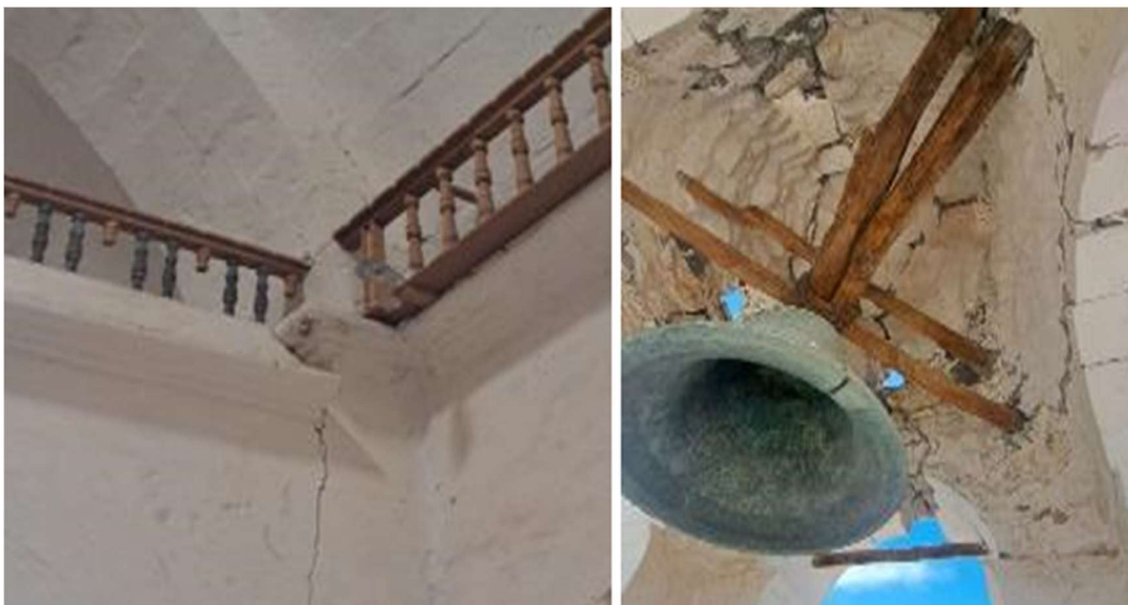
Figura 31. Elementos no estructurales
