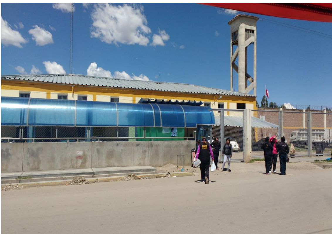
Fotografía 2. Infraestructura del Instituto Nacional Penitenciario Huamancaca
