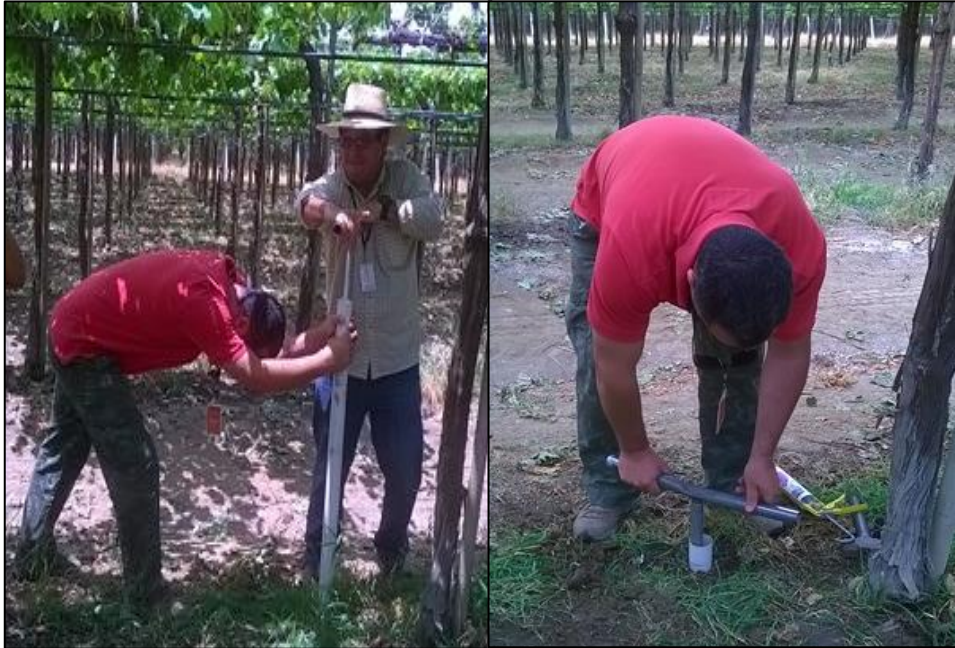
Figura 9: Instalación del tubo de acceso en campo
