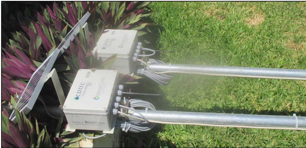
Figura 12: Armado de antena
