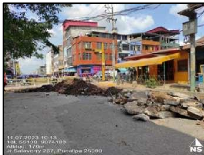
Figura 7. Lugar de extracción de la mezcla asfáltica reciclada
