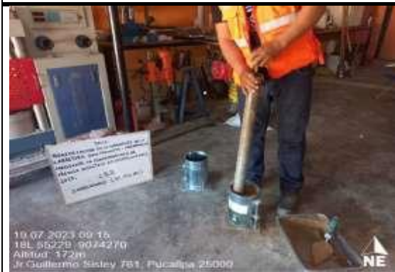
Ensayo de CBR incorporación de Mezcla Asfáltica reciclada
