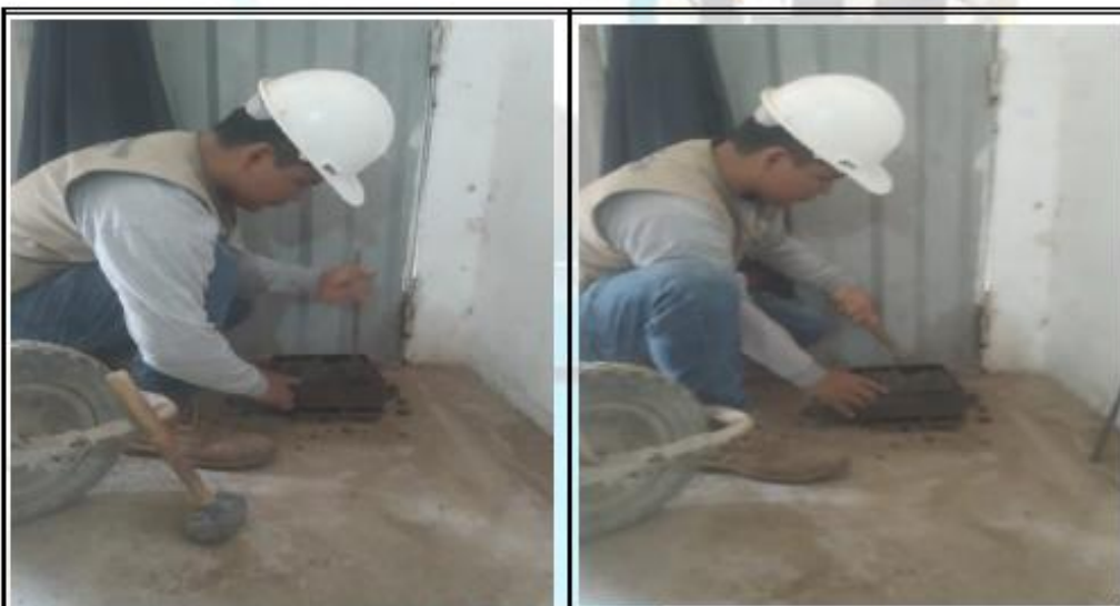
Fotos nº 11-12: En las imágenes podemos observar al personal realizando moldeo de los adoquines de concreto.
