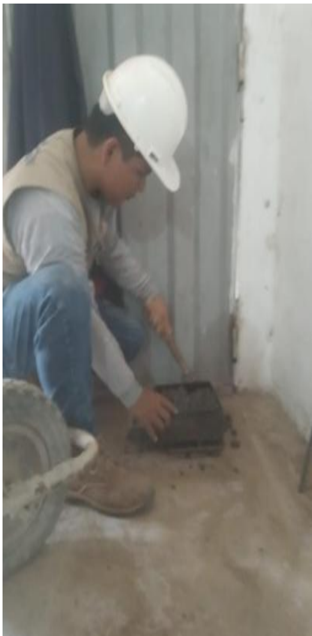
Foto 09: Colocación a los moldes de adoquines
