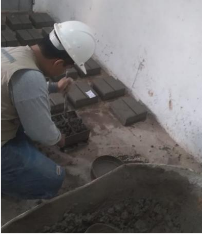
Foto 09: Colocación a los moldes de adoquines
