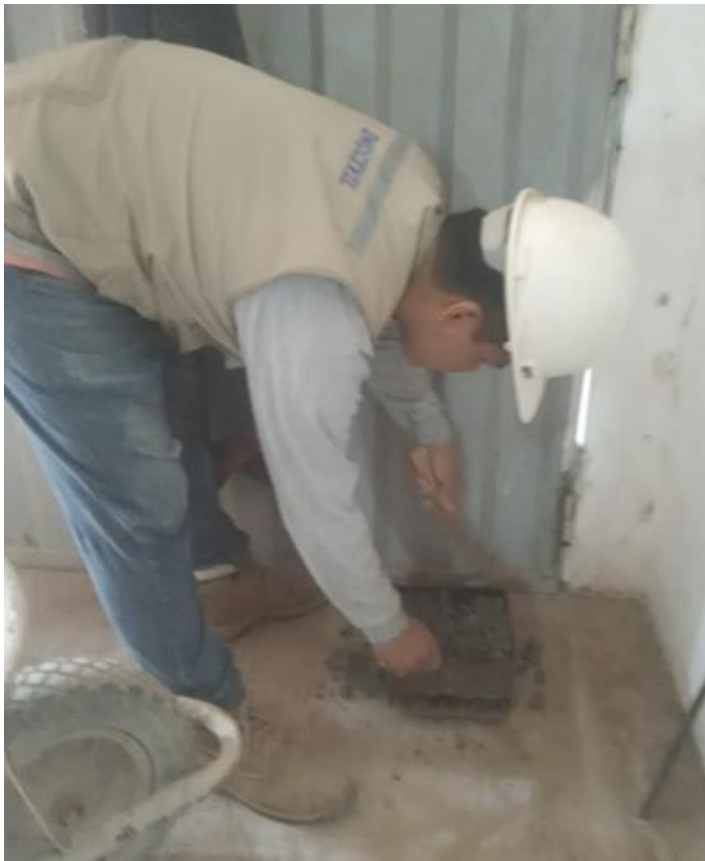
Foto 09: Colocación a los moldes de adoquines
