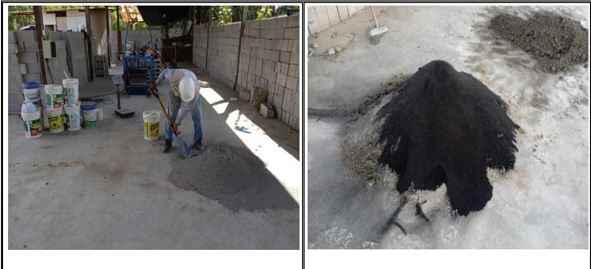
Fotos nº 13-14: En las imágenes podemos observar la preparación de mezcla de concreto para los bloques.
