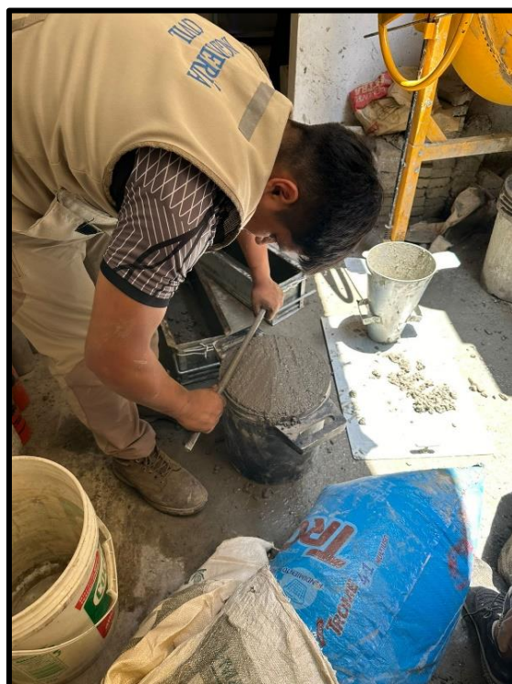
FOTO 17: revestimiento y llenado Fuente: elaboración propia (2023)
