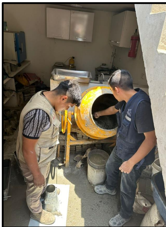
FOTO 6: Mezcla de materiales para elaboración de concreto
