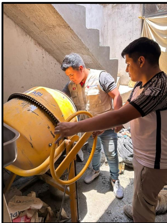
FOTO 12: Mezclado de agregados y agua para elaboración de vigas
