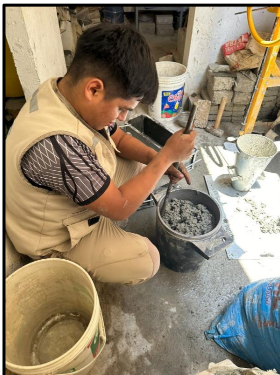
FOTO 16: varillado de concreto Fuente: elaboración propia (2023)
