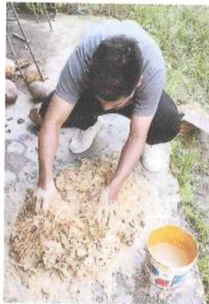
Foto 9. Proceso del mesclado de agregados
