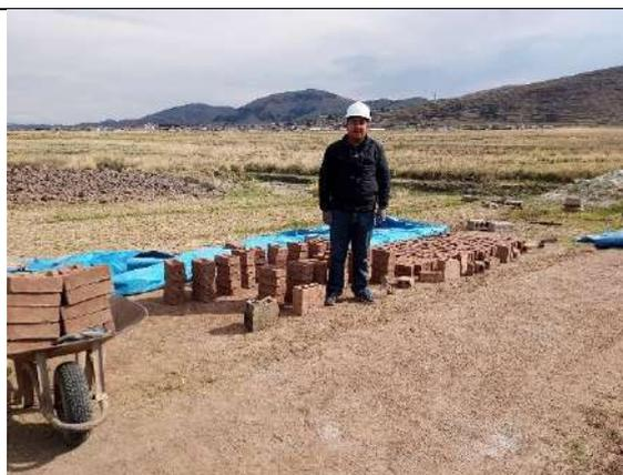
**Fotografía 16:** Transporte del ladrillo para cargar al horno
