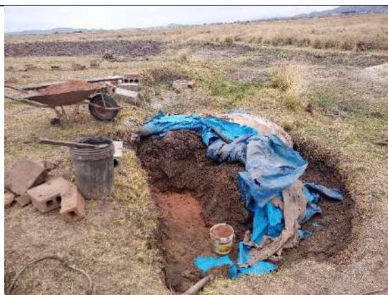
**Fotografía 10:** Proceso de reposo de la masa por una noche
