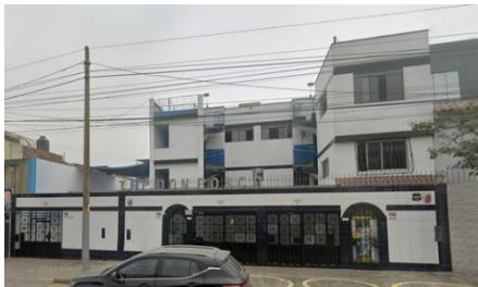
Foto N°3: Colegio Foto N°2: Colegio Don Bosco
