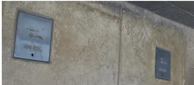
Foto N°1: Buzones en Av. del aire.
