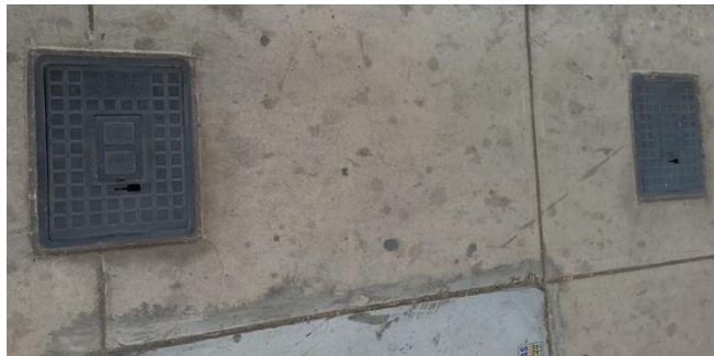
Foto N°3: Buzones en Rio Piura
