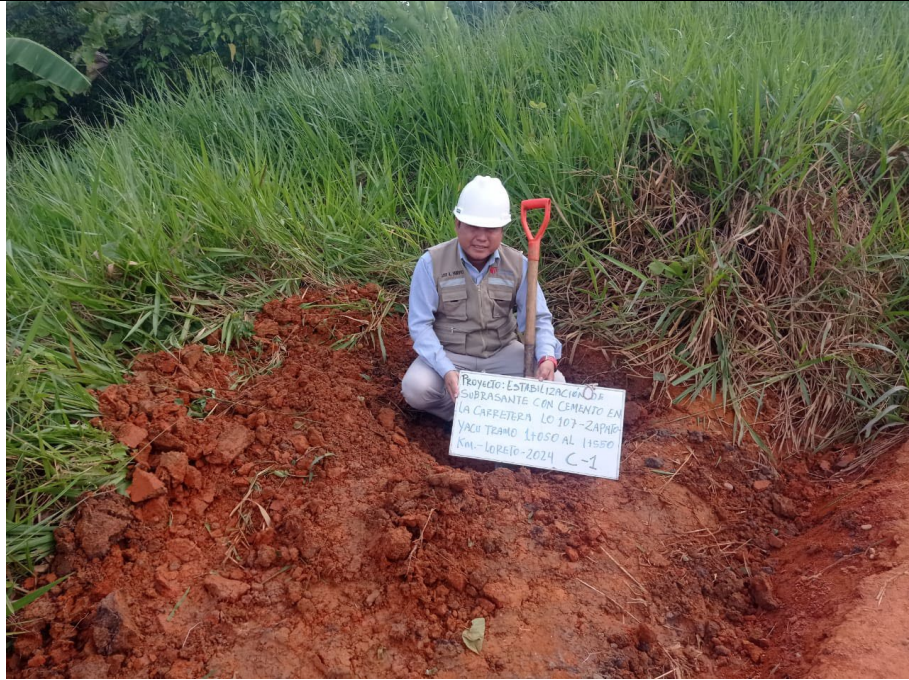
Foto n° 06: Excavación de calicata N°01
