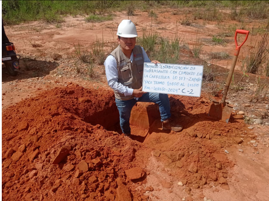
Foto n° 08: Excavación de calicata N°02
