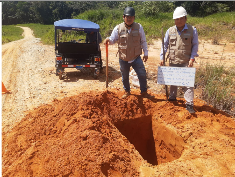
Foto n° 09: Excavación de calicata N°02
