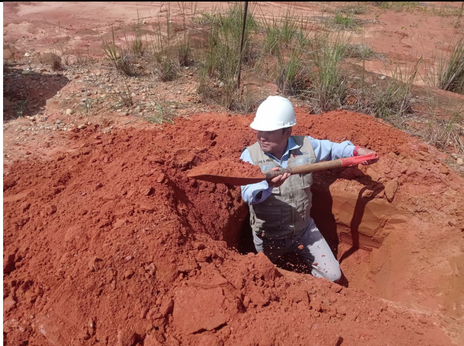
Foto n° 07: Excavación de calicata N°01
