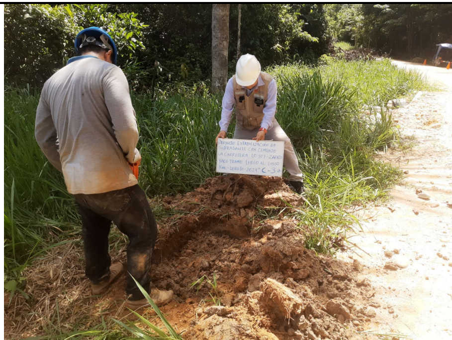
Foto n° 11: Excavación de calicata N°03
