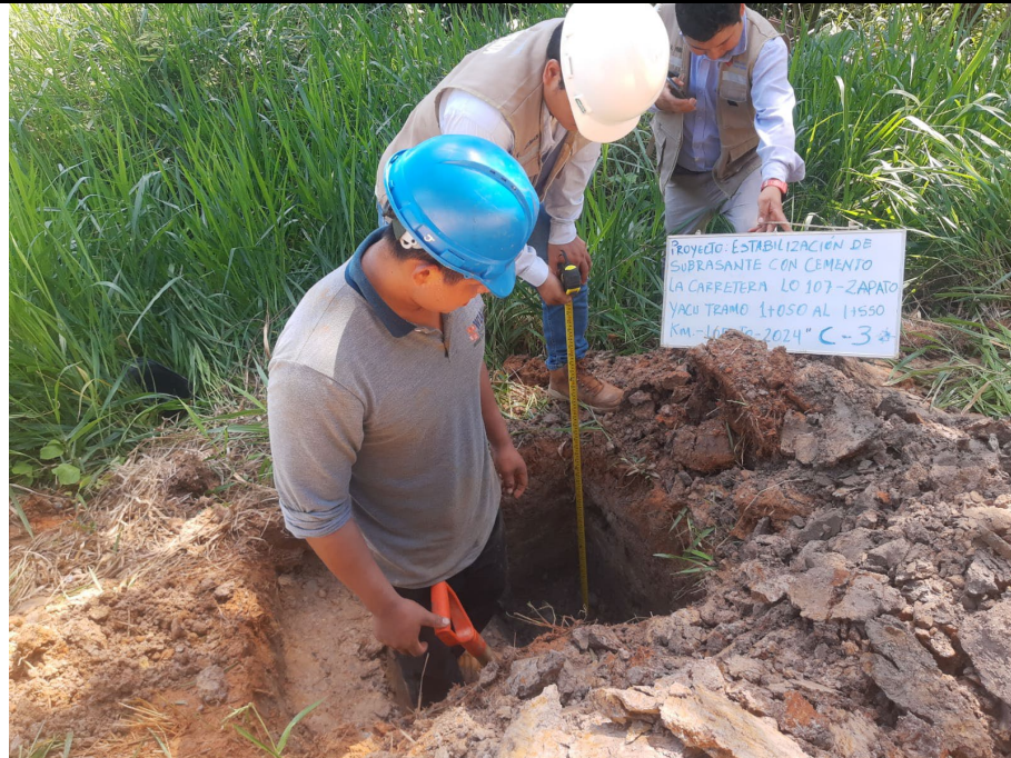
Foto n° 10: Excavación de calicata N°03
