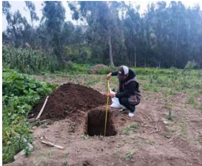
Figura 41. Verificación de la calicata
