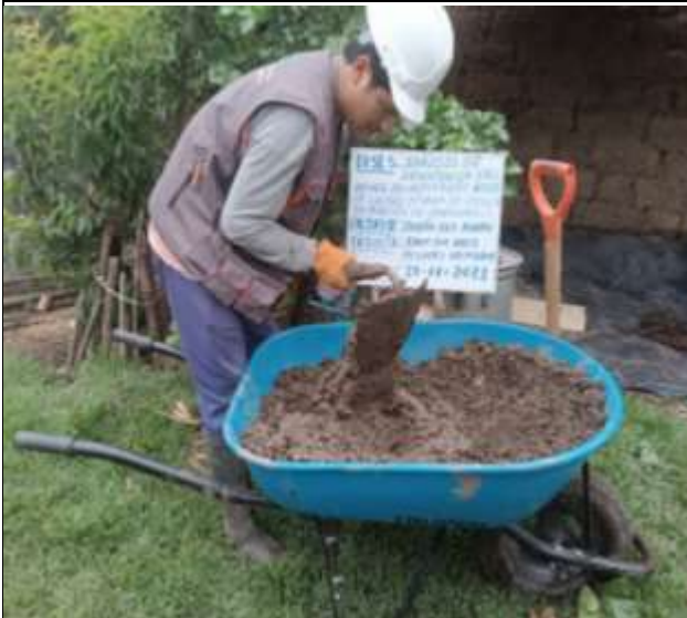
Mezclado de la Arcilla 70% + arena 30% y los aditivos naturales según procedimiento norma técnica E 0.80
