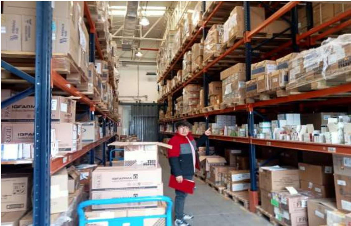
Autoconstrucciones de acero sin criterio técnico (sensibilidad sísmica)
