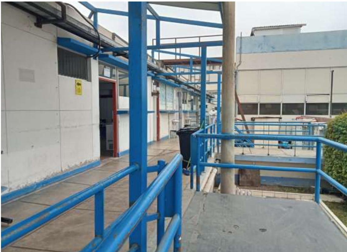
Construcciones prefabricadas sin reforzamiento estructural (sensibilidad sísmica)
