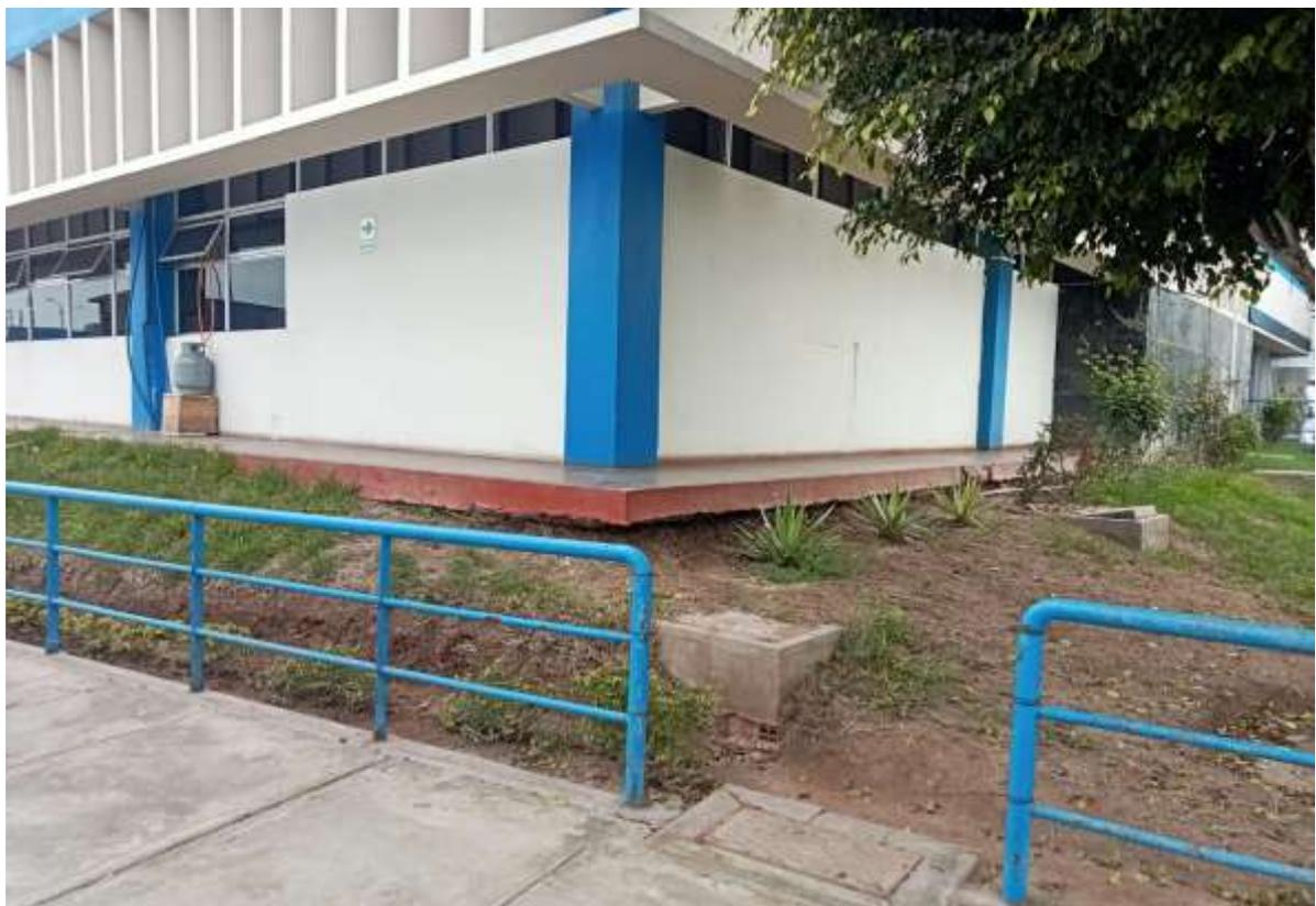
Cimentación expuesta a la humedad (desintegración del concreto, corrosión de las armaduras)
