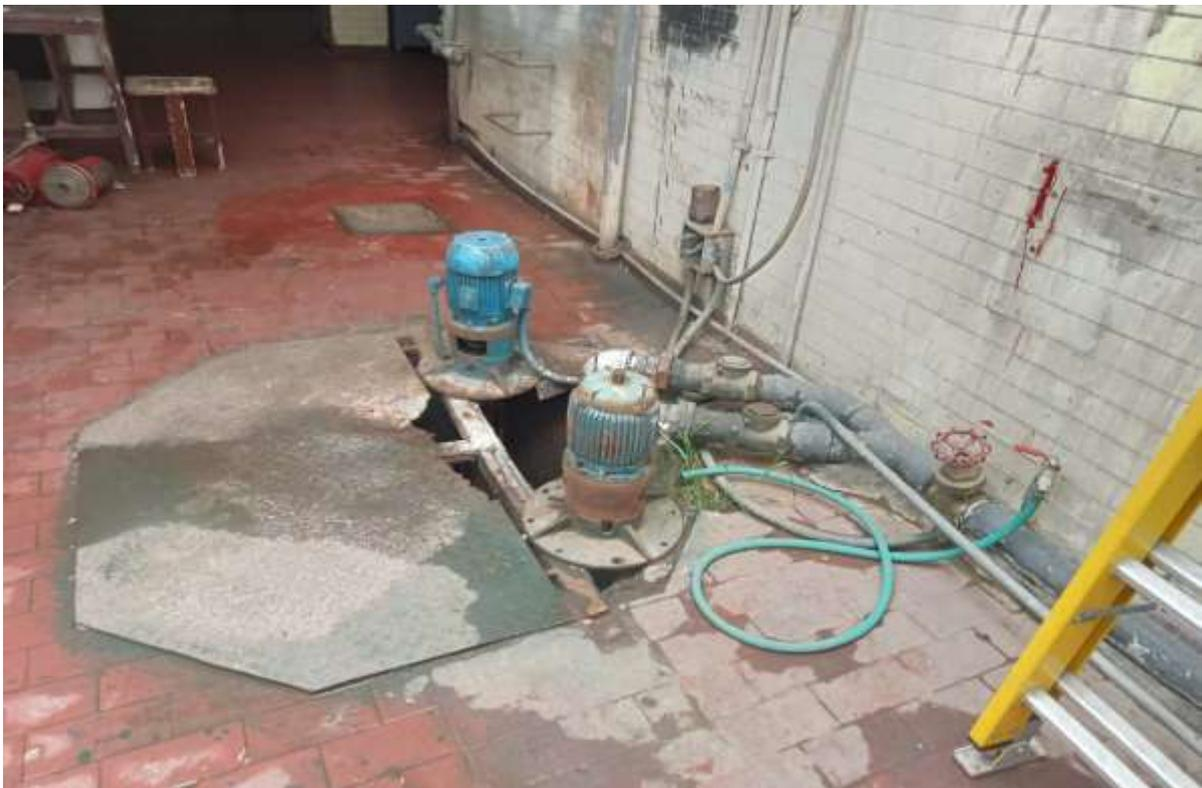
Líneas vitales expuestas, sin anclajes antisísmicos, sin protección (sensibilidad sísmica)
