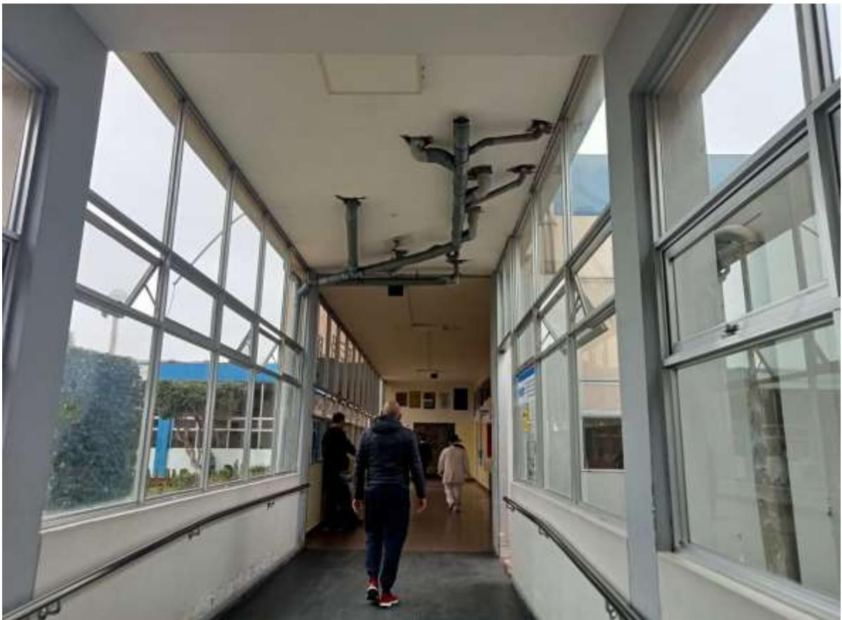
Líneas vitales mal diseñadas, sin anclajes de seguridad (sensibilidad sísmica)
