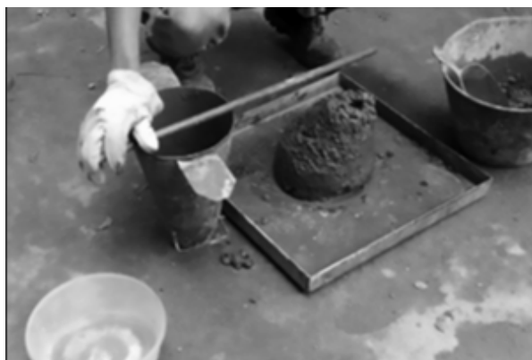
Figura 5 . Ensayo de asentamiento Fuente: (CURE, 2023, pág. 3)
