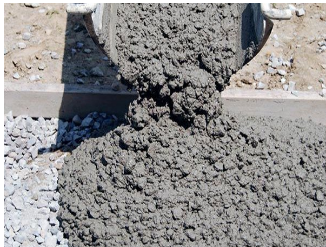
Figura 3. Concreto en estado fresco
