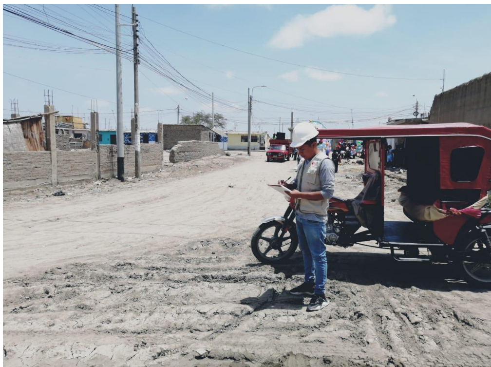
Figura 04: Conteo vehicular estación 02 – Calle Argentina– Centro Poblado La Unión – Distrito de Pomalca - Lambayeque Fuente: Elaboración Propia
