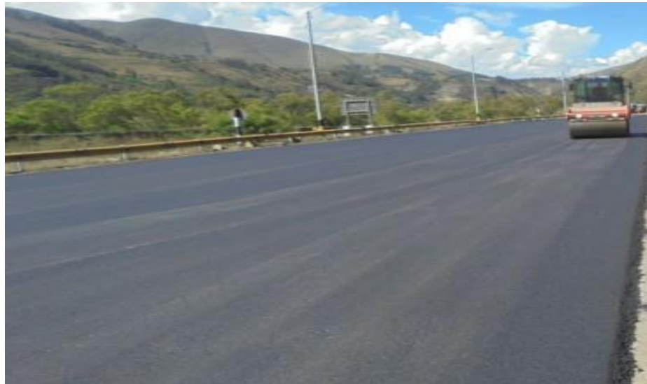
Imagen 1.1. Acabado de una vía asfaltada
