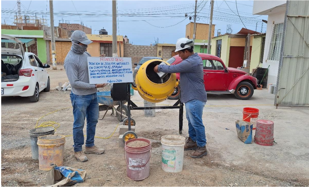
VACIADO DE MEZCLA
