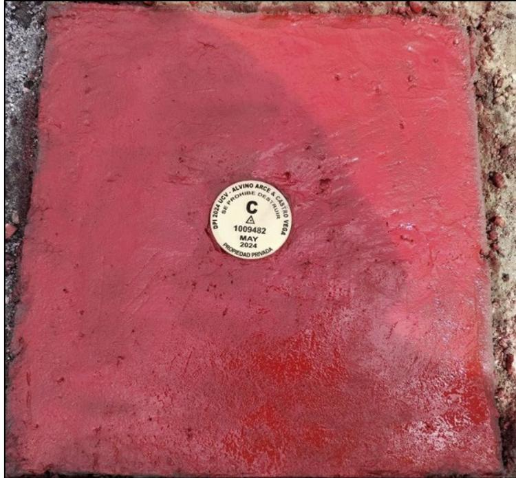
*Figura 8:* Monumentación de hito de concreto terminado con el disco de bronce instalado.
