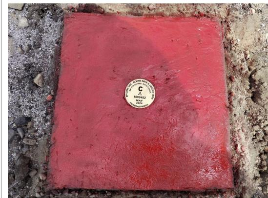
Foto 12: Hito de concreto con el disco de bronce instalado.
