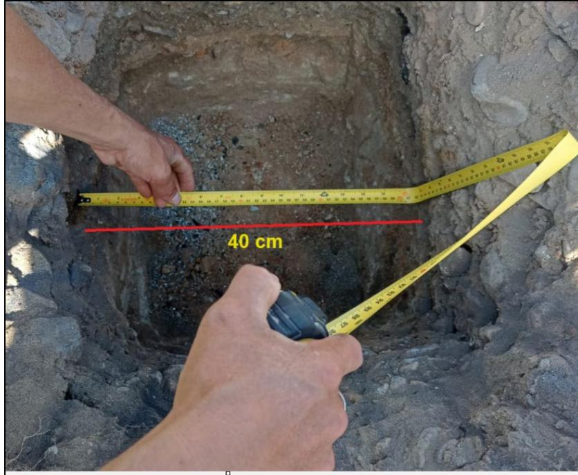
*Figura 6:* Ancho de excavación de punto geodésico = 40 cm
