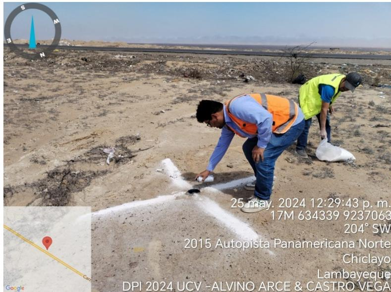
Figura 11: Marcado de Punto de Apoyo Fotogramétrico sobre el terreno
