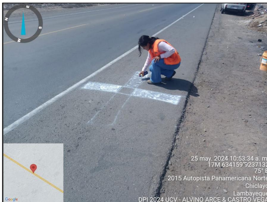
Figura 16: Marca blanca sobre el terreno que servirá de guía para el despegue y aterrizaje del equipo.
