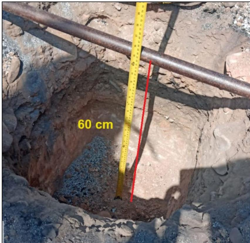
*Figura 7:* Profundidad de excavación de punto geodésico no menor a 60 cm
