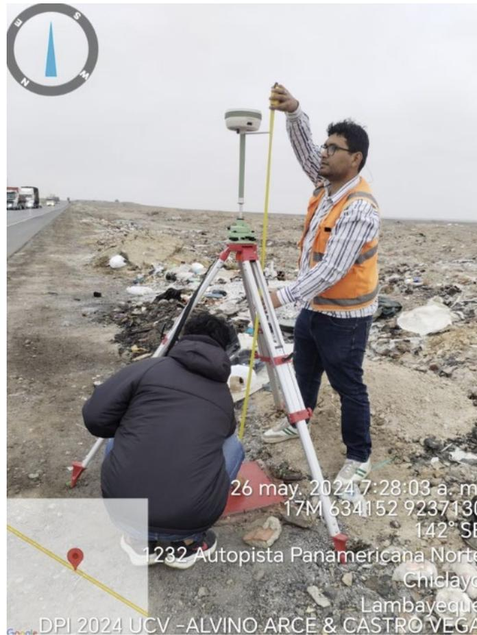
Figura 9: Instalación de receptor GNSS sobre punto de control.
