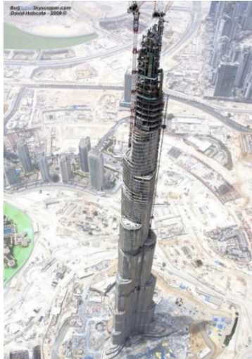
Figura 10: Torre de Dubái en ejecución,
