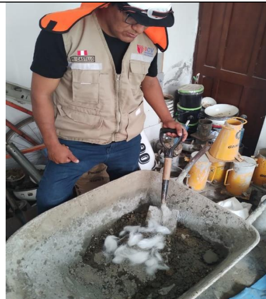
Preparación de mezcla
