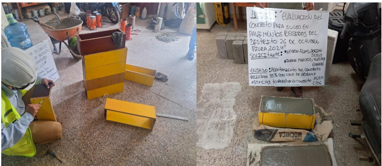
Figura 8. Elaboración de vigas de concreto
