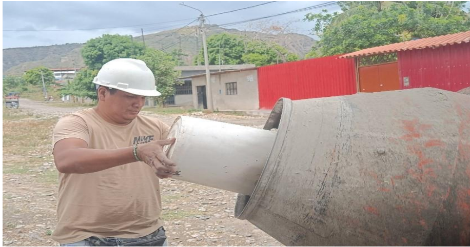
Figura 28. Elaboración de concreto con 4% de cenizas Fuente: elaboración propia
