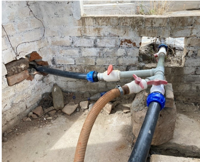
Figura 8. Instalación de la bomba sumergible
