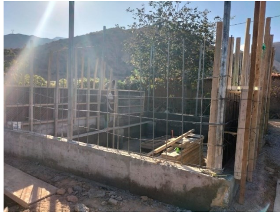
Figura 6. Acabados del pozo de almacenamiento de agua
