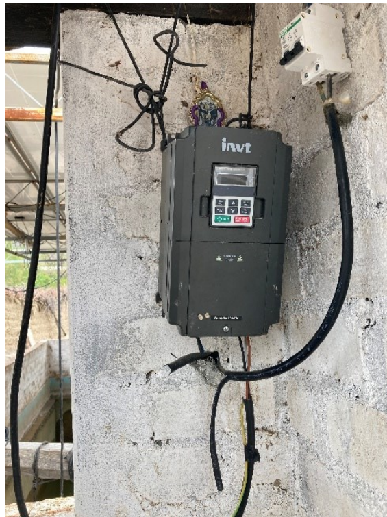
Figura 11. Instalación del controlador fotovoltaico
