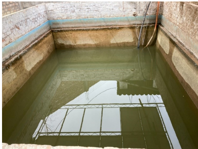
Figura 7. Adaptación del pozo para el sistema de bombeo
