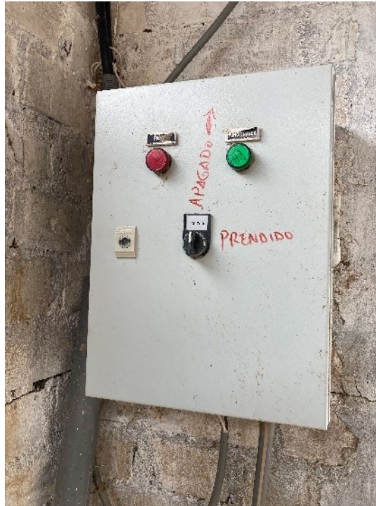
Figura 12. Instalación del controlador eólico
