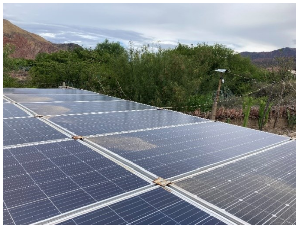
Figura 9. Instalación de los paneles solares
