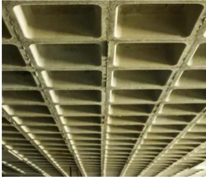
Figura 3. Losa nervada (Max Acero Monterrey, 2023)
