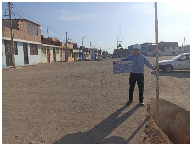
Figura 30. Excavación de Calicata N°03
