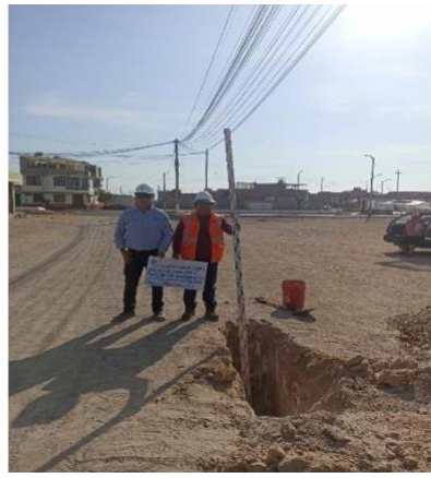
Figura 2. Excavación de calicata N a 03 en la zona de 24 de octubre calle 12.
