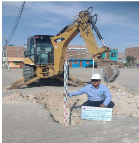
Figura 28. Excavación Calicata N°01
