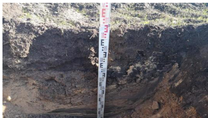
Figura 21. Medición Altura de calicatas H= 1.5m Fuente: Elaboración Propia
