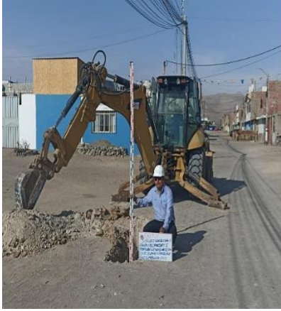
Figura 1. Excavación de calicata N a 02 en la zona de 24 de octubre calle 12.
