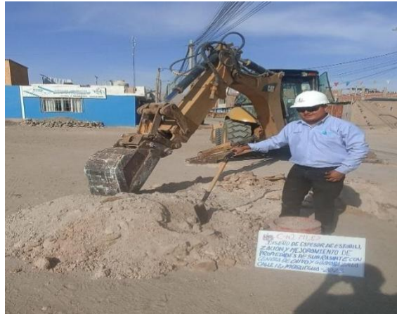
Figura 29. Excavación Calicata N° 02
