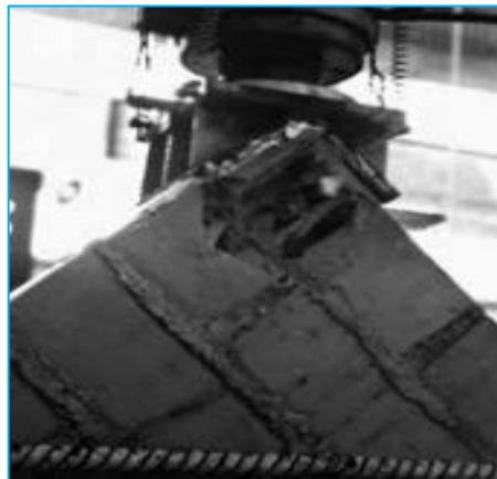
Figura 15. Falla local. Fuente: (SAN BARTOLOME, 2018, pág. 92)
