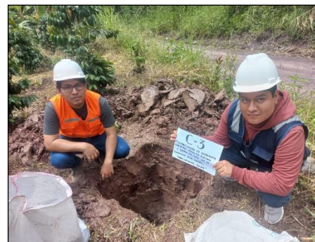
Realización calicata 03 Fuente: Elaboración propia (2024)
