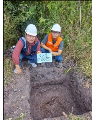
Realización calicata 01 Fuente: Elaboración propia (2024)
