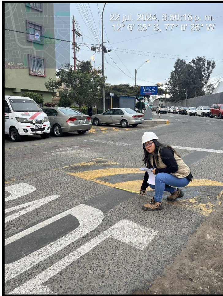
Figura 11: Patología Parqueo– Elaboración propia.
