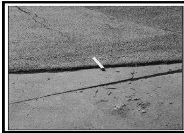
Figura 16: Patología Desplazamiento– Fuente: Norma ASTM D6433.
