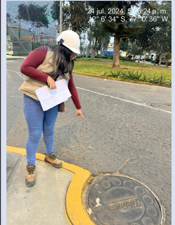
IMAGEN 01 - PATOLOGIA DE HINCHAMIENTO - CUADRA 03 - MUESTRA 01 - LADO IZQUIERDO
